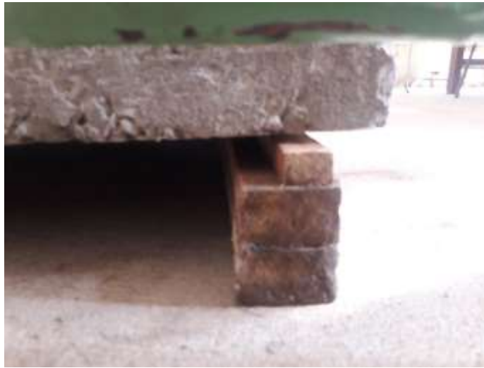
Figura N° 77 Proceso para inclinar la losa al 2%.
