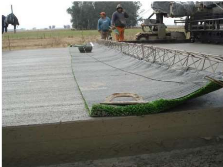
Figura N° 11 Texturizado por arrastre de césped sintético
