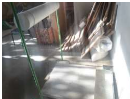
Figura N° 81 Descarga del tubo a la losa.
