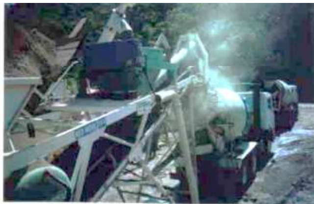
Figura N° 9 Entrega del hormigón para su transporte
