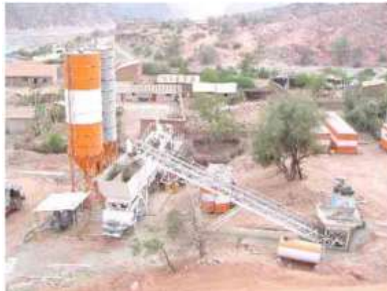
Figura N° 7 Planta de producción de hormigón.
