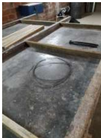
Figura N° 42 Moldes para losas 80x80cm.
