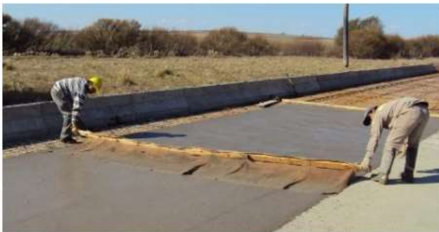
Figura N° 10 Texturizado manual con arpillera
