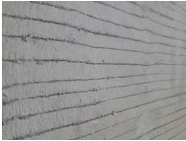
Figura N° 49 Losa texturizada con peine metálico.
