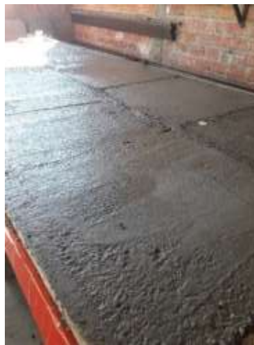
Figura N° 43 Vaciado de hormigón fresco.
