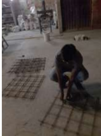
Figura N° 41 Armado de parrillas para losas.
