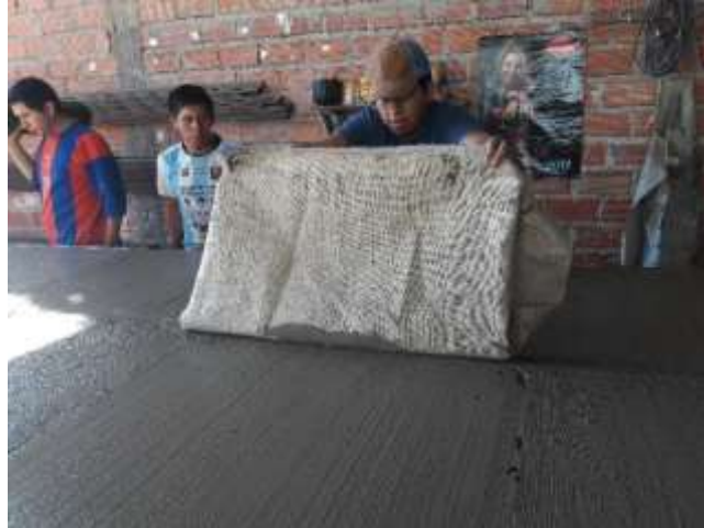
Figura N° 47 Texturizado con tela arpillera.
