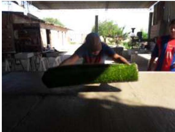
Figura N° 44 Texturizado con césped sintético.
