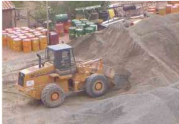
Figura N° 8 Almacenamiento de grava y arena.
