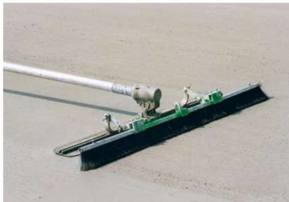
Figura N° 12 Texturizado con cepillo en sentido transversal (manual)
