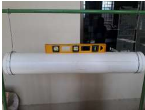
Figura N° 79 Nivelado del tubo.
