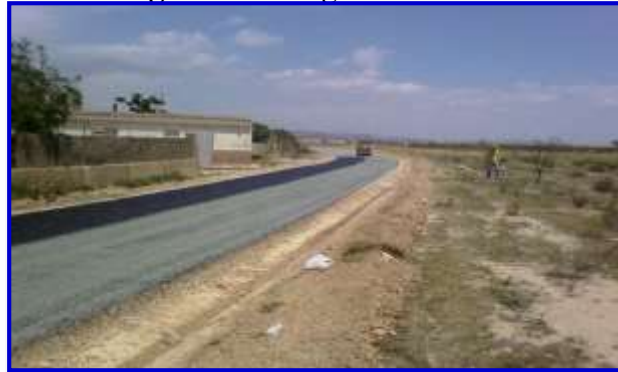
Figura 2.7. Riego de curado
