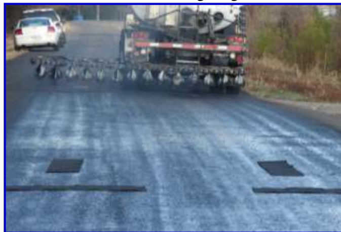
Figura 2.21. Método de medición del riego según la norma ASTM D2995
