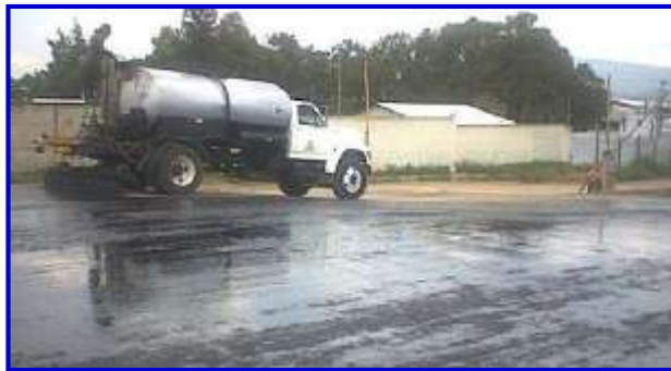
Figura 2.6. Riego de imprimación
