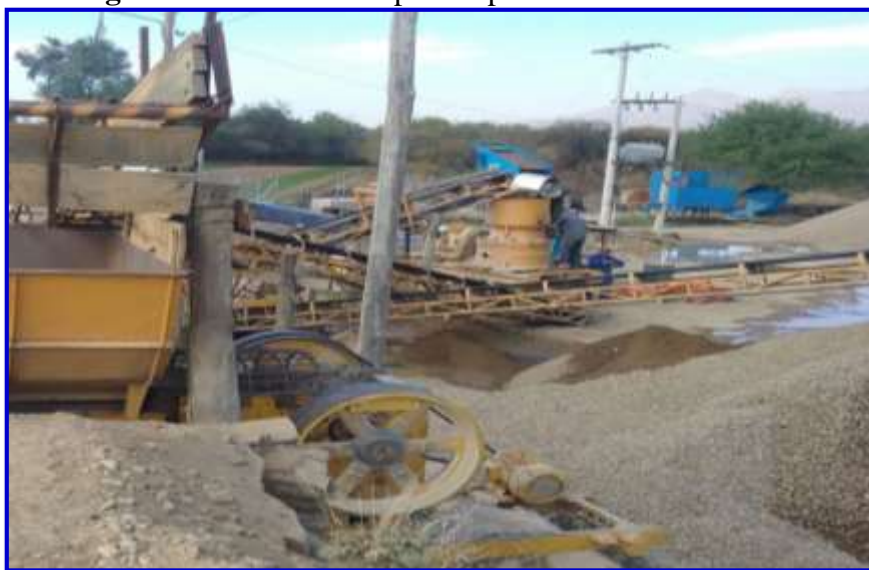
Figura 3.2. Chancadora para la provisión de material
