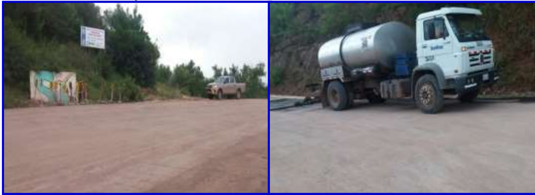
Figura 3.114. Riego de imprimación para la conformación de la carpeta asfáltica Proyecto de asfaltado de la carretera Entre Ríos – Palos Blancos
