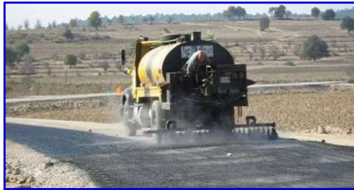
Figura 2.14. Aplicación de riego de liga
