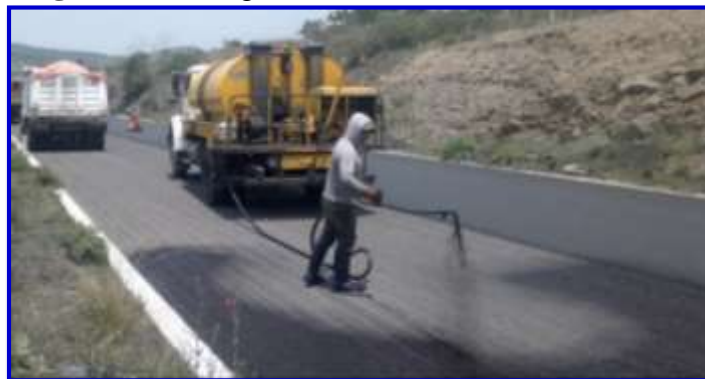
Figura 2.19. Riego de adherencia manualmente
