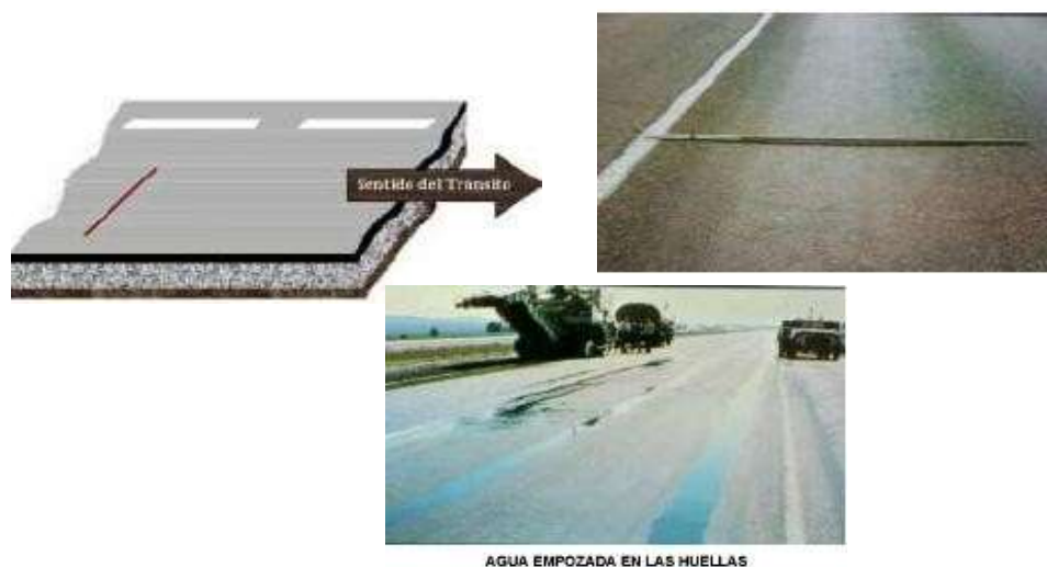
Figura N°8: Daño por ahuellamiento
