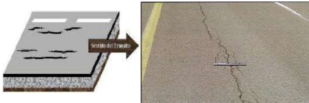
Figura N°6: Fisura longitudinal
