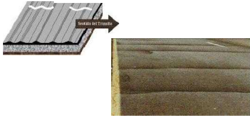
Figura N° 10: Daño por corrugación
