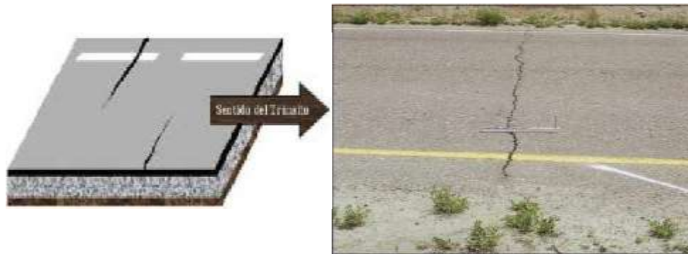
Figura N°5: Fisura transversal
