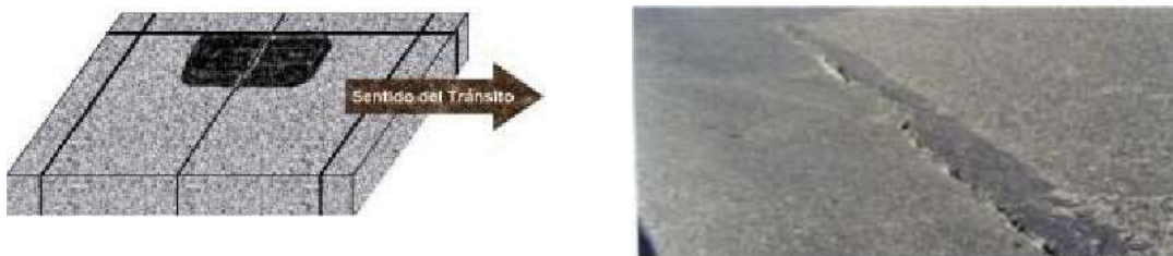
Figura N°7: Fisura por reflexión de juntas
