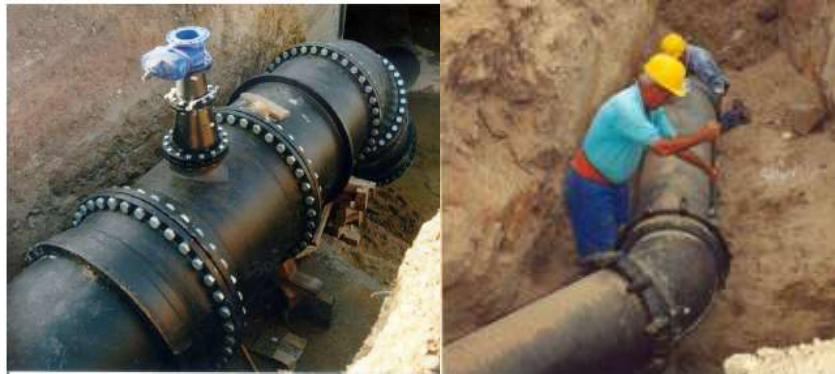
Fotografía 3-1: JUNTA CON BRIDAS
