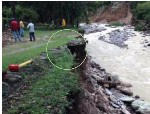
Fotografía 5-2: CANAL DEL RINCÓN DE LA VICTORIA DESTROZADO
