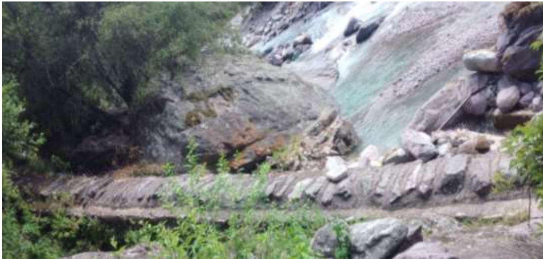
Fotografía 5-1: CANAL DE LA VICTORIA
