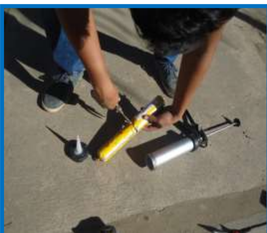
Figura 3.104: Instalación del Sikaflex®
