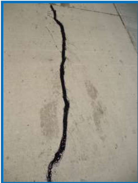
Figura 3.107: Grietas selladas en los tramos
