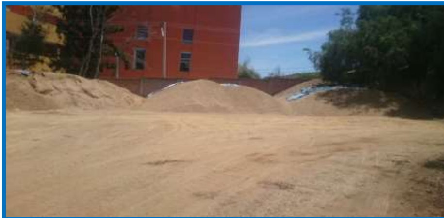
Figura 3.31: Centro de acopio de material
