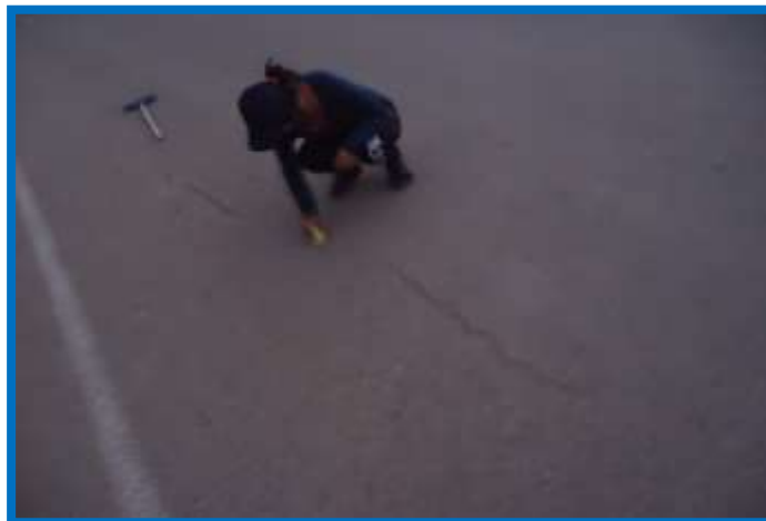
Figura 3.82: Limpieza de fisura a sellar
