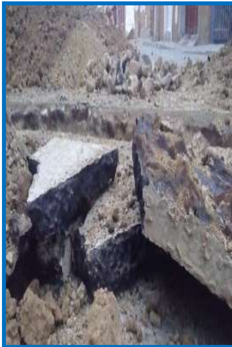
Figura 3.67: Carpeta asfáltica de donde se extrajeron las muestras
