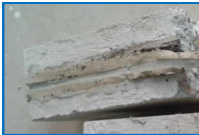
Figura 3.135: Muestra de pavimento rígido sellado con Sikaflex PRO-3 con rotura a flexión
