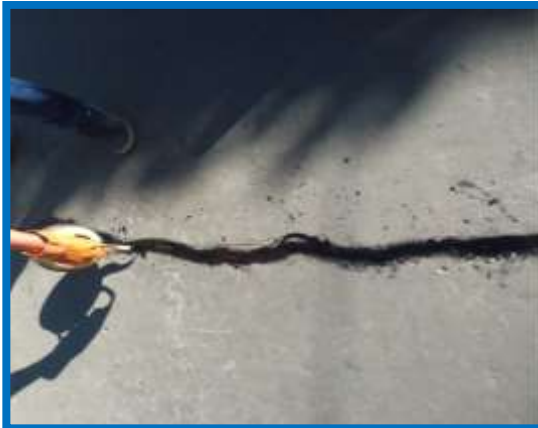
Figura 3.105: Sellado de grietas
