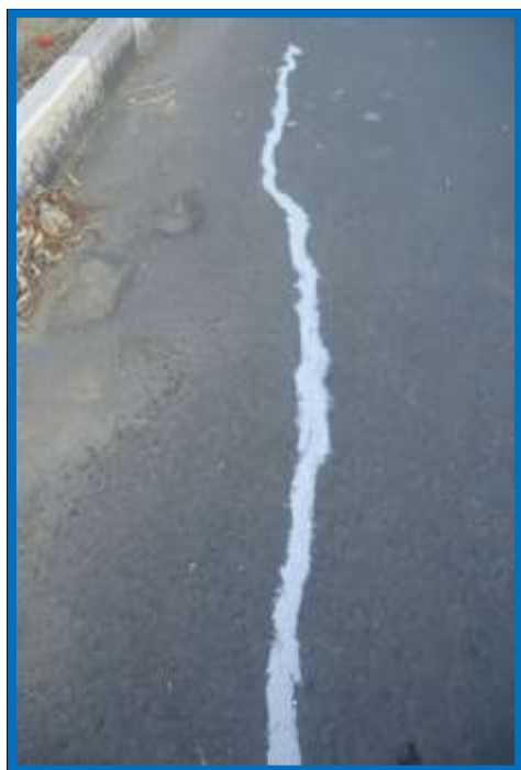
Figura 3.87: Fisuras selladas en los tramos
