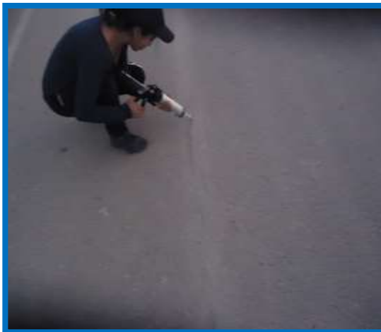
Figura 3.86: Aplicación del sello Sikaflex® PRO-3
