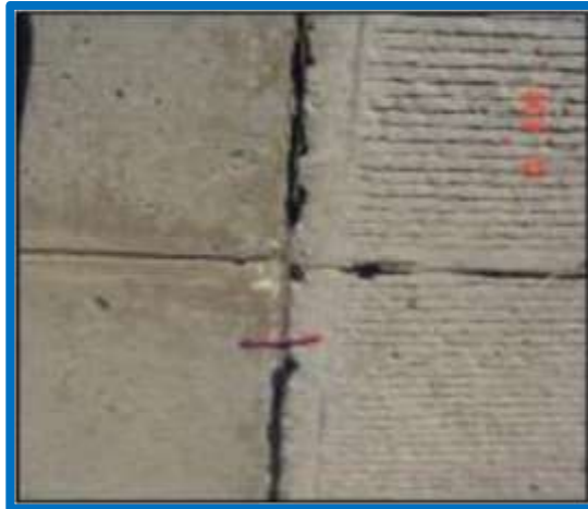
Figura 2.17: Vista típica de deterioro del sello
