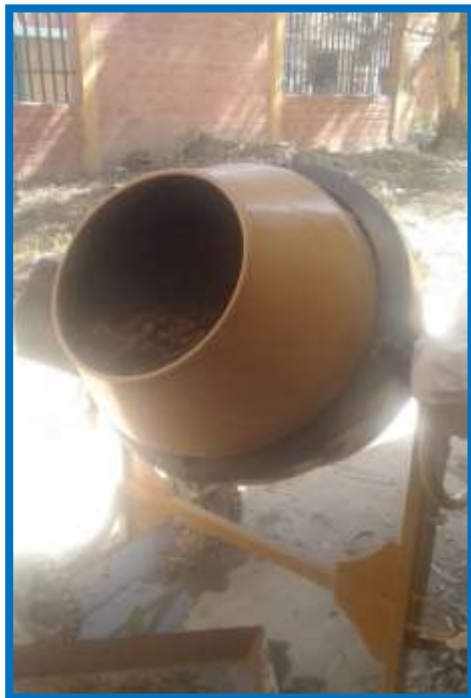
Figura 3.88: Preparación del hormigón
