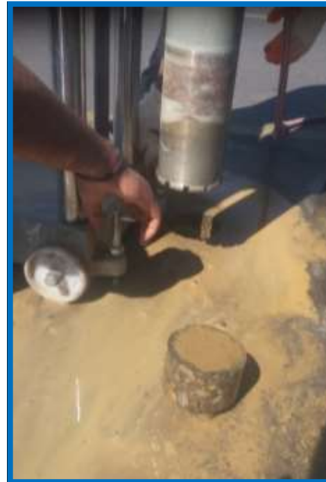
Figura 3.68: Extracción de muestras de carpeta asfáltica
