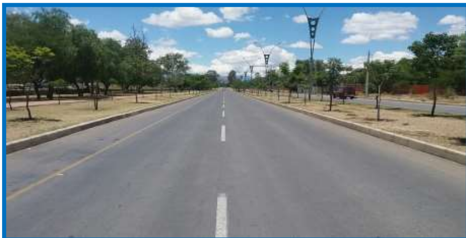
Figura 3.17: Avenida La Banda
