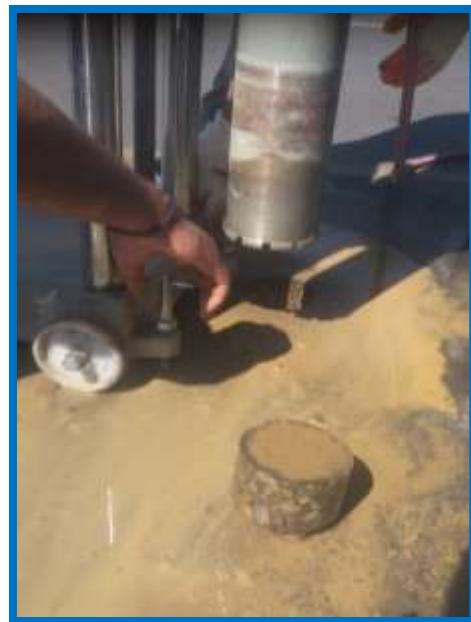
Figura 3.26: Extracción de testigos
