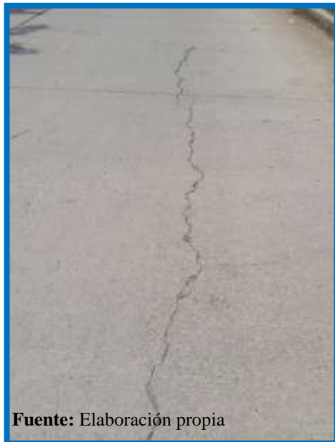
Figura 3.55: Grieta longitudinal
