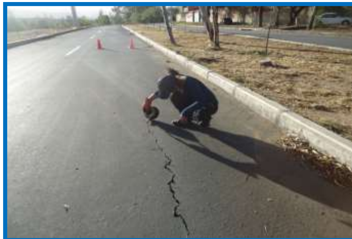
Figura 3.85: Aplicación de los sellos en caliente
