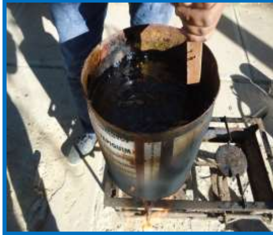
Figura 3.84: Mezclado del sellante
