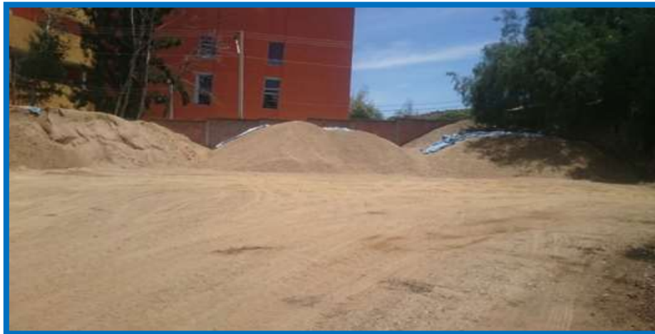
Figura 3.38: Centro de acopio para la provisión del material
