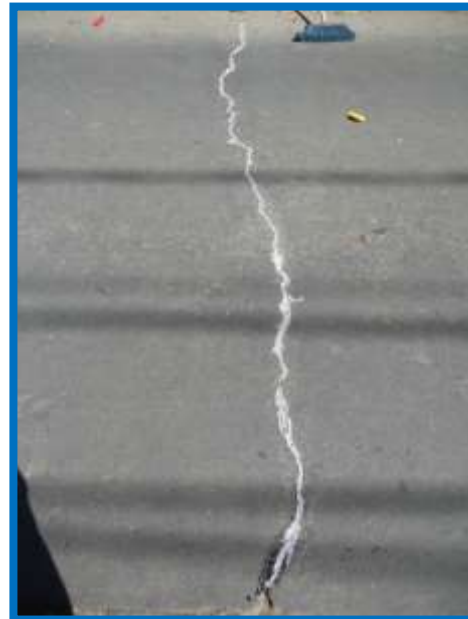
Figura 3.107: Grietas selladas en los tramos
