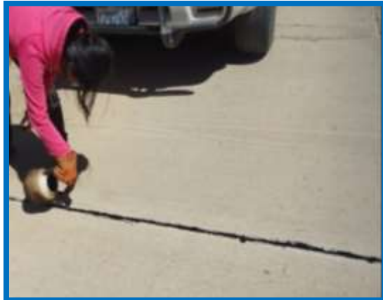
Figura 3.106: Sellado de juntas
