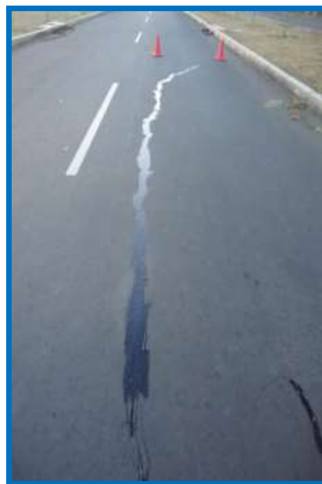
Figura 3.87: Fisuras selladas en los tramos
