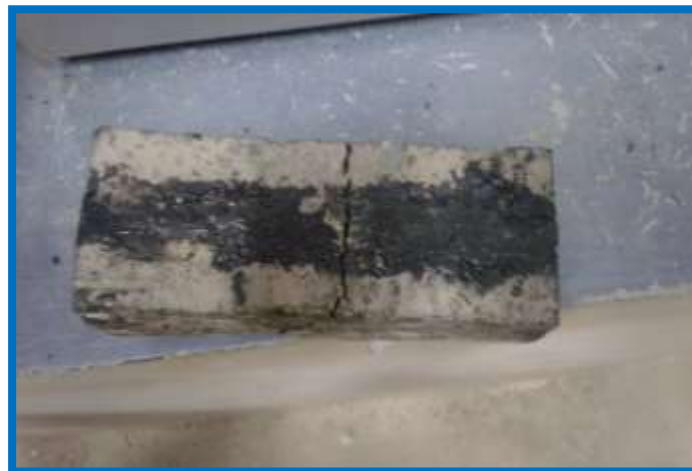
Figura 3.117: Muestra de pavimento flexible sellada con alquitrán con rotura a flexión
