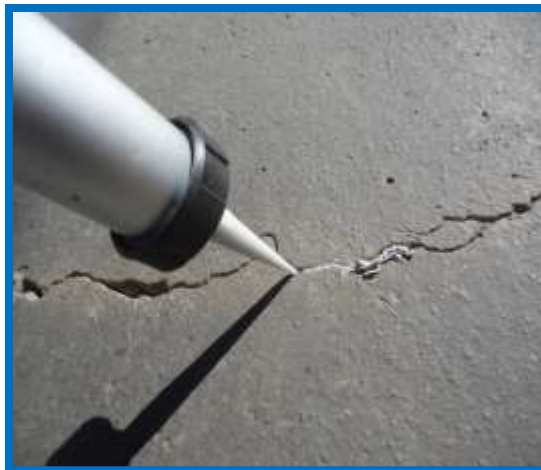
Figura 3.86: Aplicación del sello Sikaflex® PRO-3
