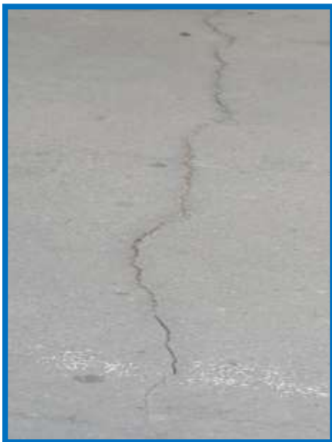
Figura 3.52: Fisura transversal
