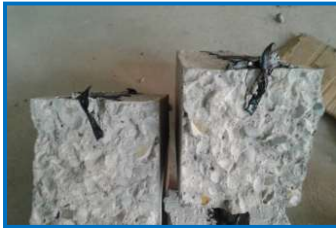
Figura 3.131: Muestras de hormigón selladas con mástic asfáltico con rotura a flexión
