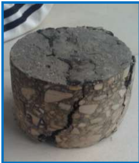
Figura 3.114: Muestra de pavimento flexible sellada con mástic asfáltico con rotura a compresión
