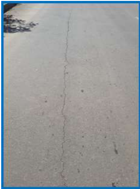
Figura 3.51: Fisura longitudinal
