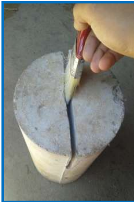
Figura 3.92: Limpieza de la superficie a sellar
