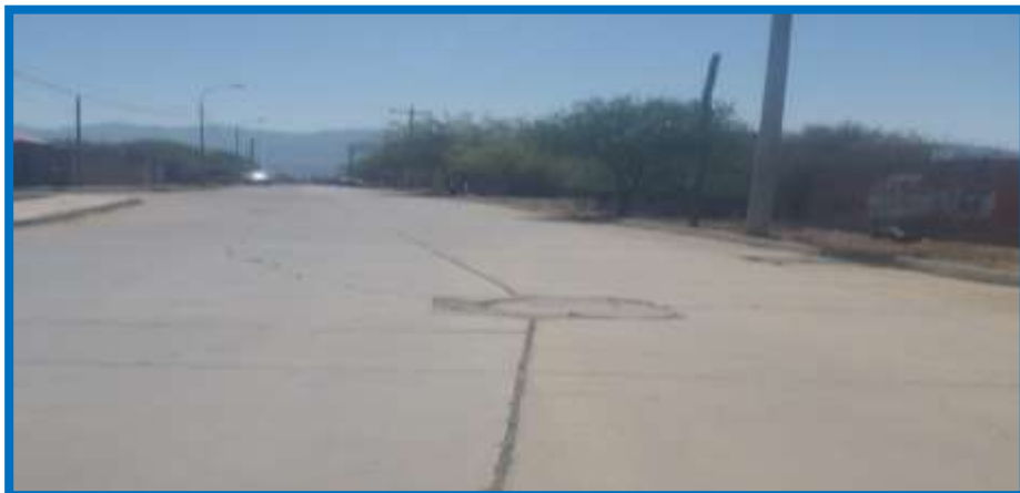
Figura 3.23: Avenida de ingreso al Hotel Los Parrales
