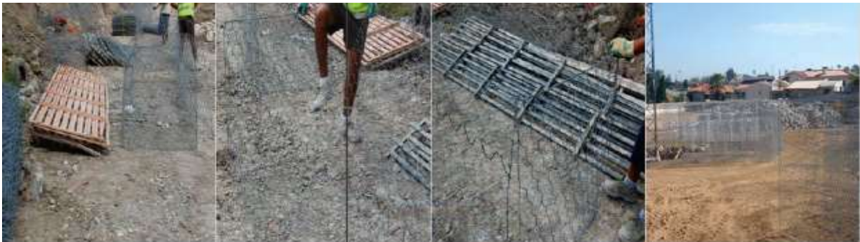
Figura 4.3. Instalación de gaviones 1er paso.
