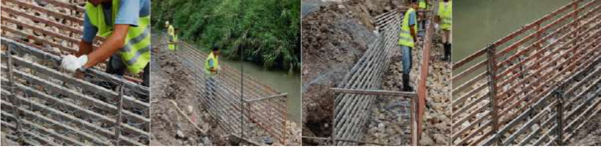
Figura 4.4. Instalación de gaviones 2do paso.
