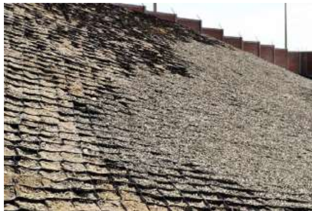
Figura 4.20. Talud con geoceldas rellenas de agregado.
