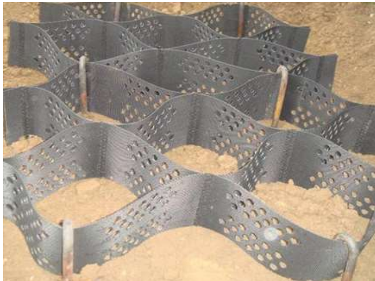
Figura 4.17. Anclaje de hierro corrugado.
