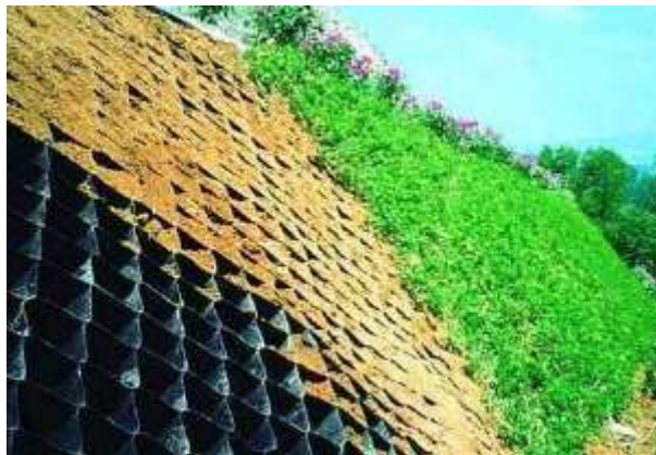
Figura 4.19. Talud con geoceldas rellenas con cobertura vegetal.
