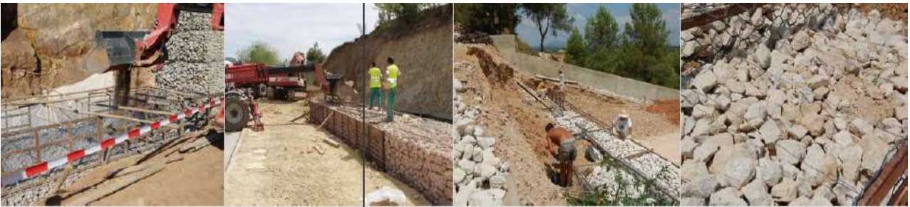
Figura 4.5. Instalación de gaviones 3er paso.
