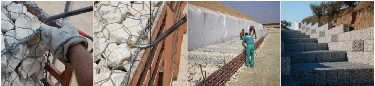
Figura 4.6. Instalación de gaviones 4to paso.
