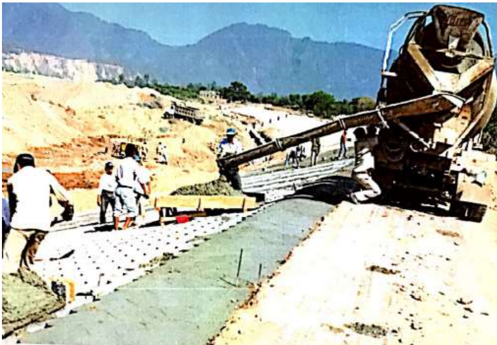
Figura 4.25. Distribución de hormigón sobre geoceldas.
