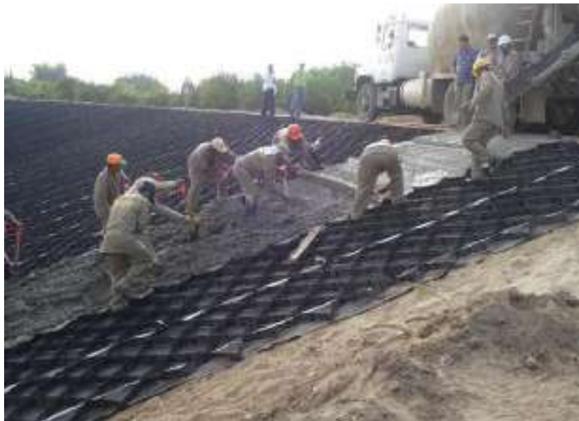
Figura 4. 21. Talud con geoceldas rellenas de concreto.
