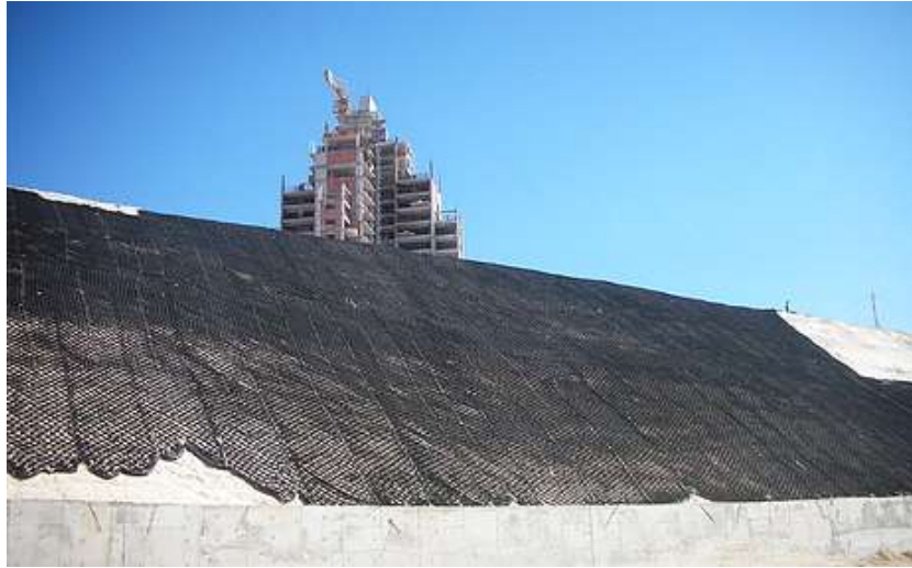
Figura 1.2. Protección de taludes con geoceldas.
