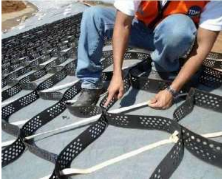
Figura 4.15. Tendones polímeros aplicados en geoceldas. Fuente: (Aguilar Aguinaga, 2016).
