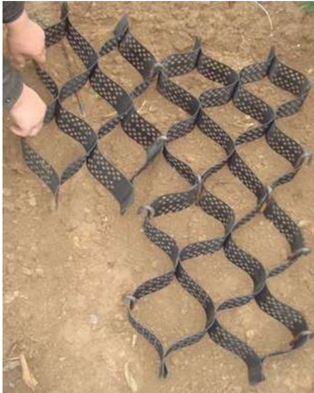
Figura 4.8. Sistema de confinamiento celular.
