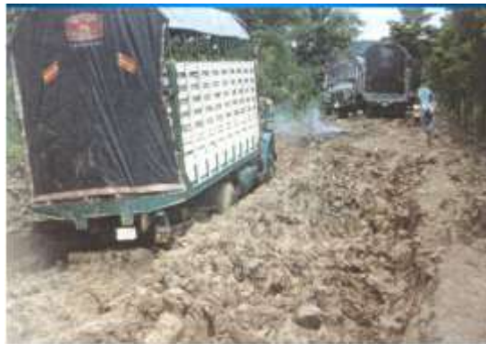
Figura ;Error! No hay texto con el estilo especificado en el documento..1 .Problemas en la subrasante
