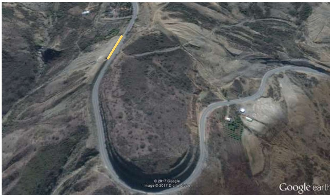
Figura N° 3.20. Vista aérea tramos de aforo de velocidad TCA 3
