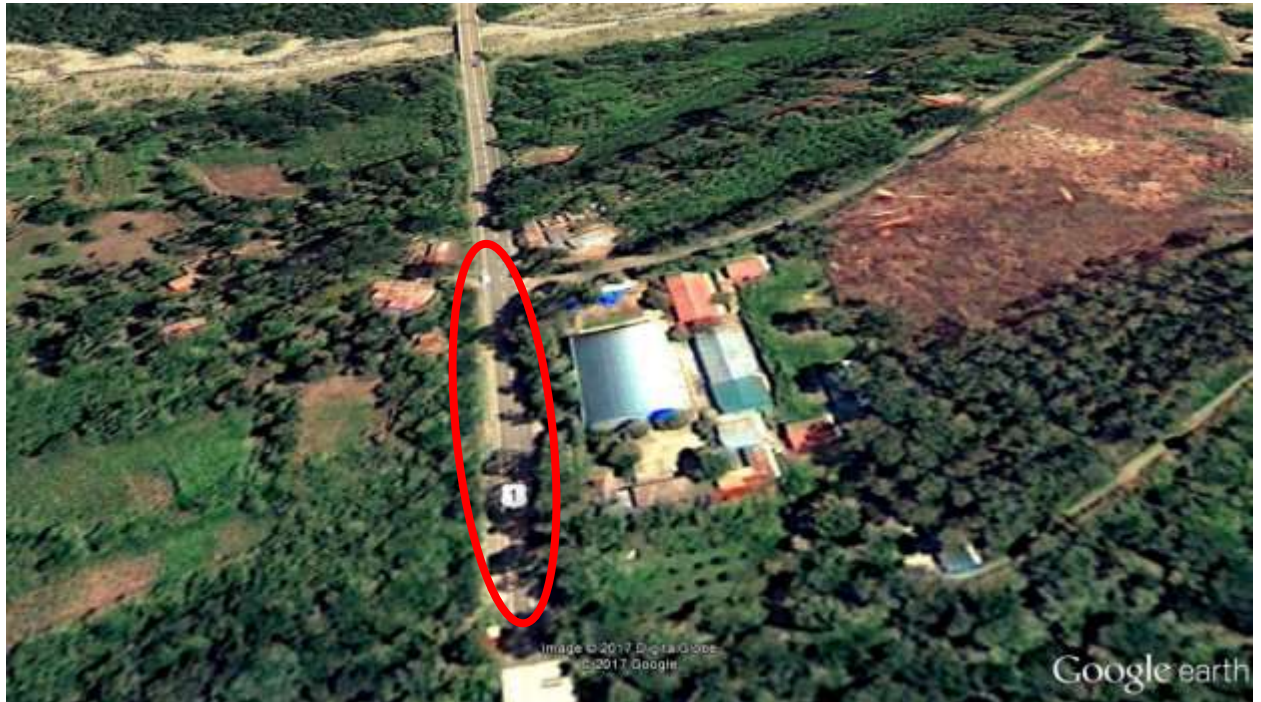
Figura N° 3.28. Vista aérea TCA 4
