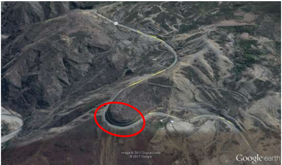
Figura N° 3.19. Vista aérea TCA 3
