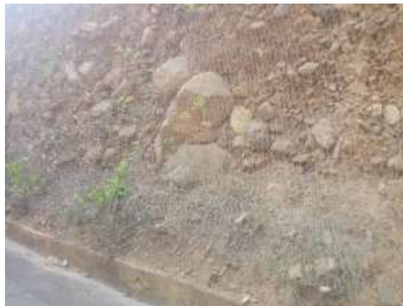
Figura N° 3.25. Mallas de protección para derrumbes TCA 3
