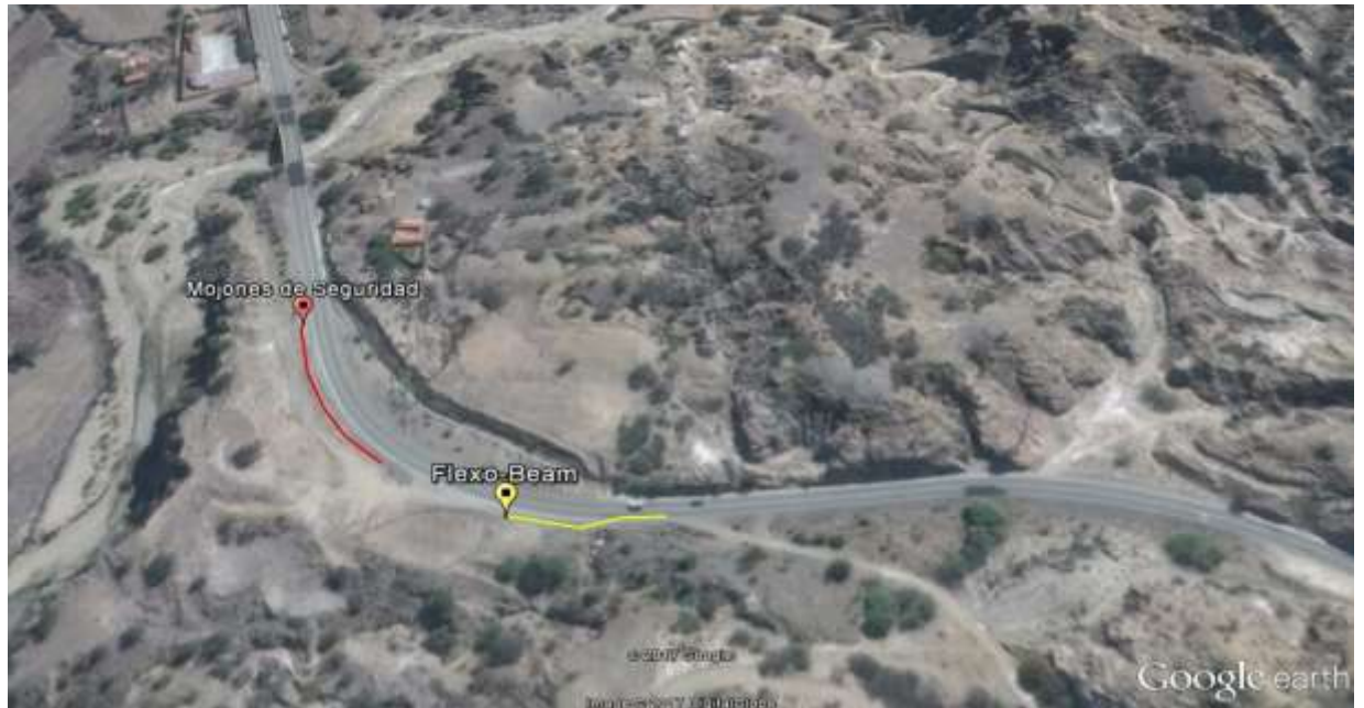
Figura N° 3.7. Vista aérea dispositivos de control TCA 1
