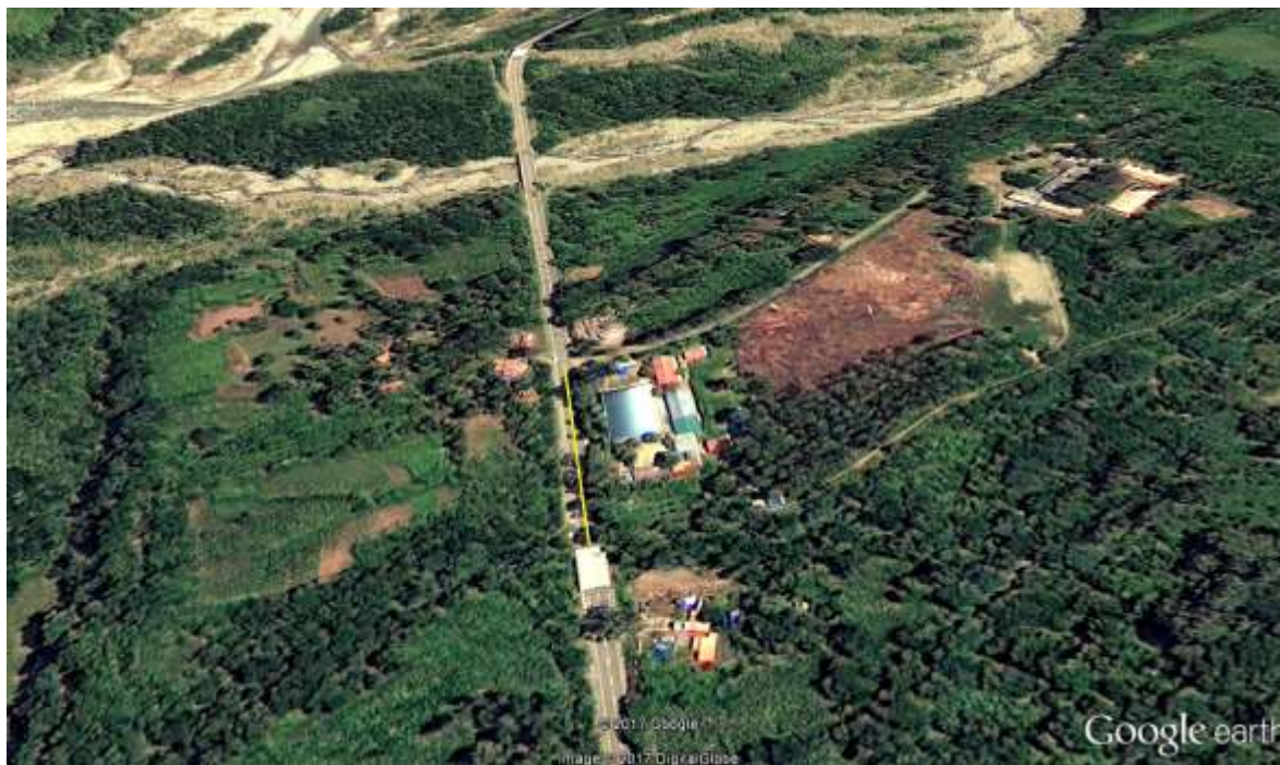
Figura N° 3.29. Vista aérea tramos de aforo de velocidad TCA 4
