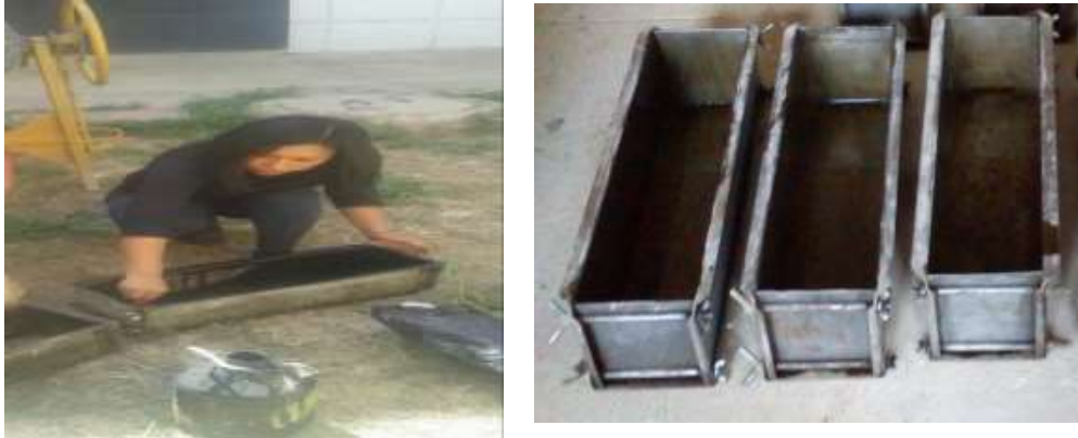
Imagen 3.22 Preparación de moldes para vigas
