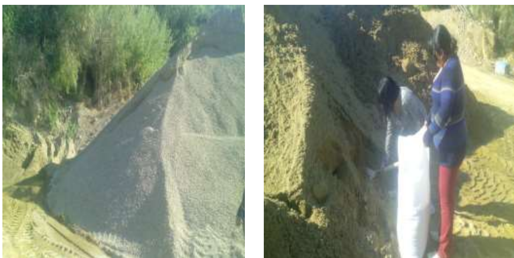
Imagen 3.1 Acopio de material
