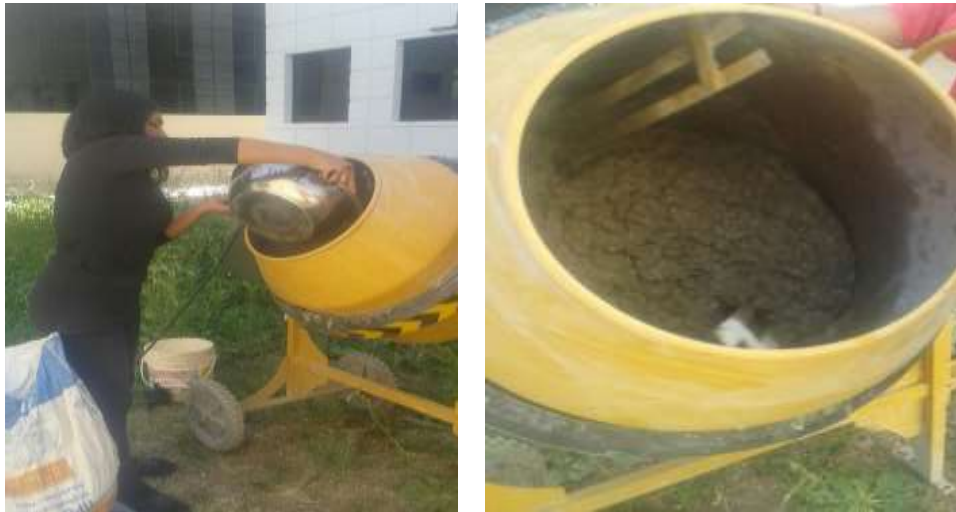
Imagen 3.23 Mezclado de hormigón
