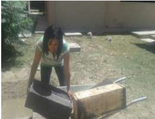
Imagen 3.27 Desmolde de vigas
