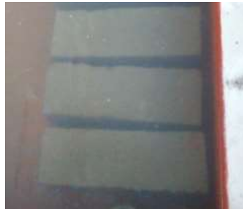
Imagen 3.28 Curado de vigas
