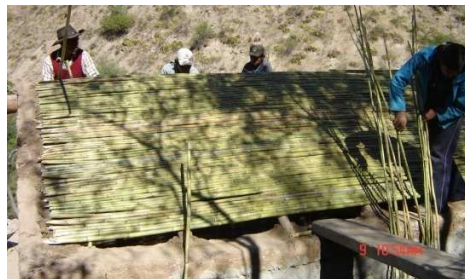
Gráfico N° 5.4 Colocado de caña
