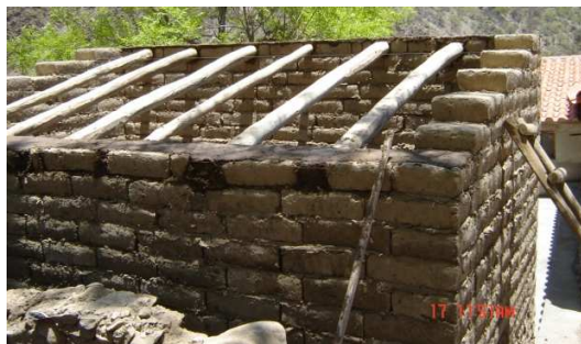
Gráfico N° 5.3 Vigas rollizas
