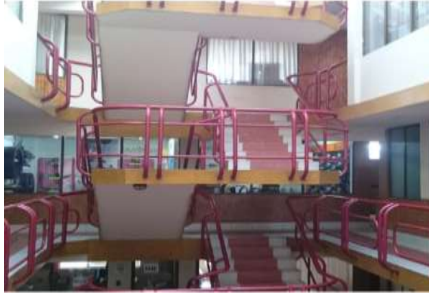
Figura 4.11 Escalera Autoportante Elaboración propia
