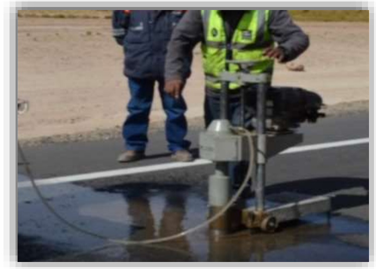
Fotografía 3.30. Dientes de la broca penetrando el pavimento
