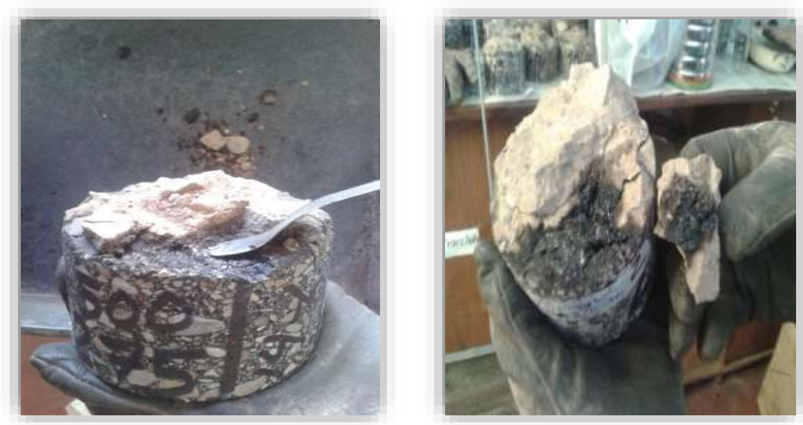
Fotografía 4.3. Núcleo del tramo con parte de la capa base
