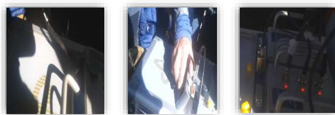
Fotografía 3.16. Conexión del cable entelnet y Encendido del módulo central
