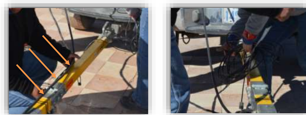
Fotografía 3.15. Cables asegurados al remolque
