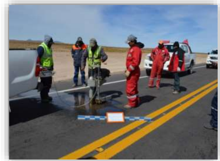
Fotografía 3.29. Extracción de núcleos al tramo de estudio
