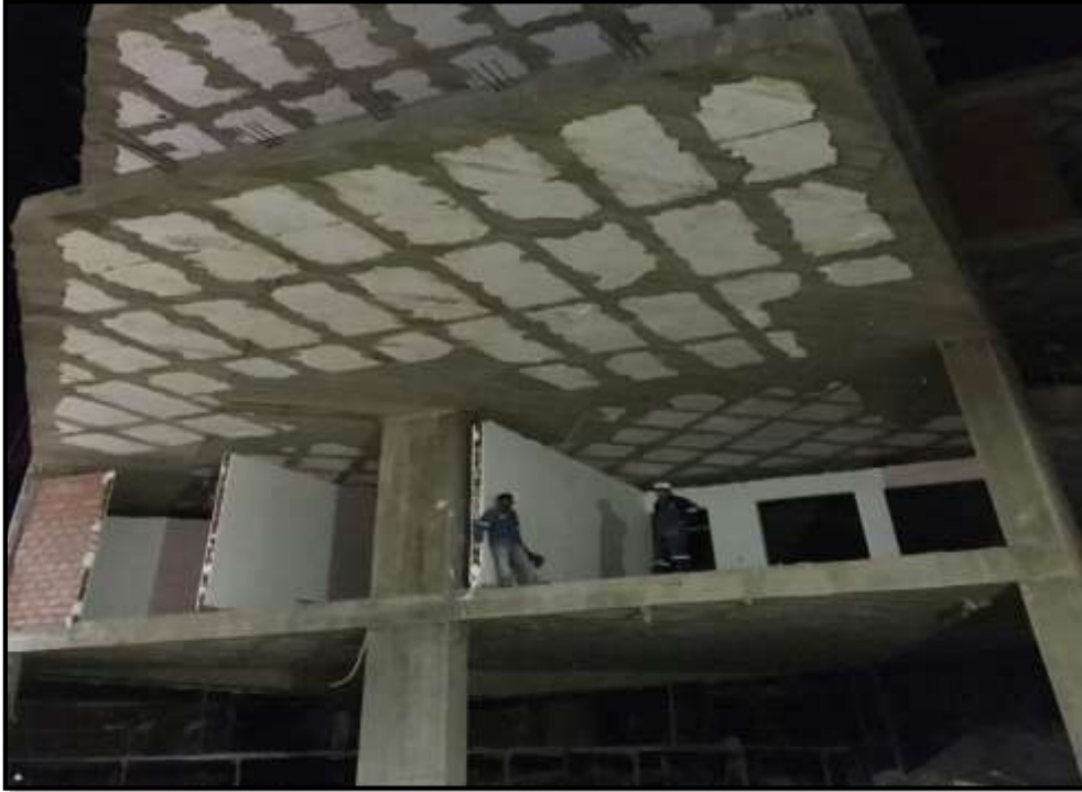
Figura N°4.1. Losa “Nervada o Reticulada”
