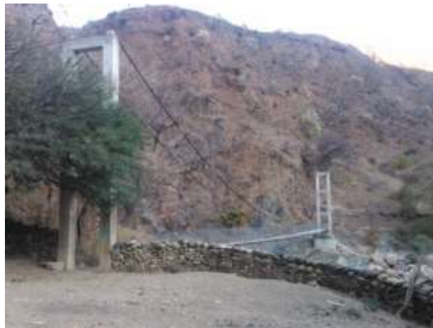
Ilustración 1: Puente Colgante Guayabillas-Baizal
