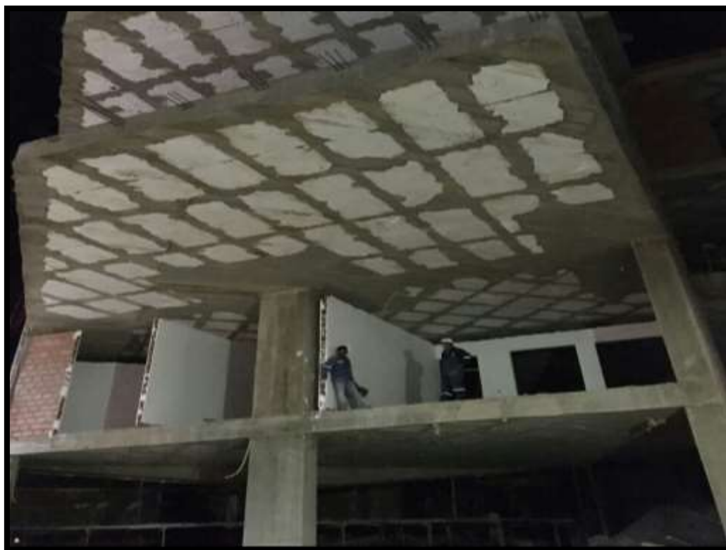
Figura N°29.4 Losa “Nervada o Reticulada”
