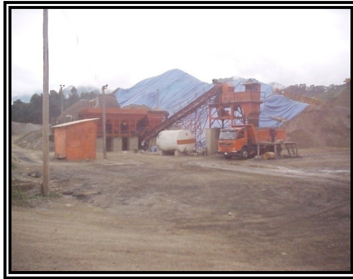
Figura N°3.17: Chancado del Material de Yacimiento
