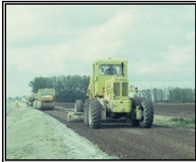
Figura N°3.19: Conformación de la Capa Sub-base
