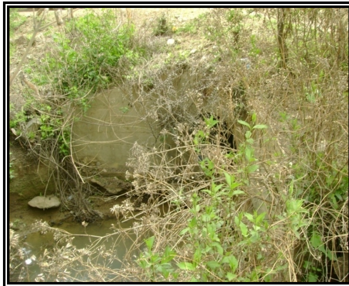
Figura N°3.1: Alcantarilla de Cruce Existente
