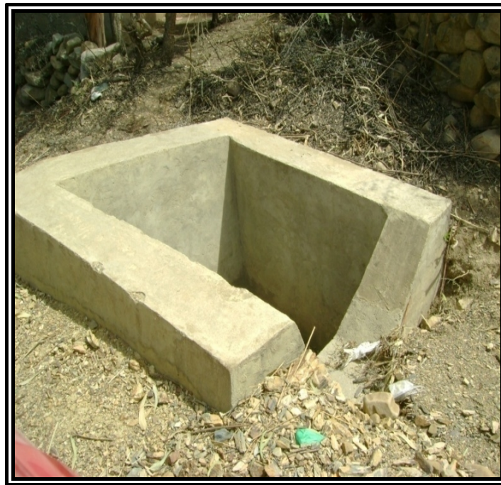
Figura N°3.7: Alcantarillado de Alivio
