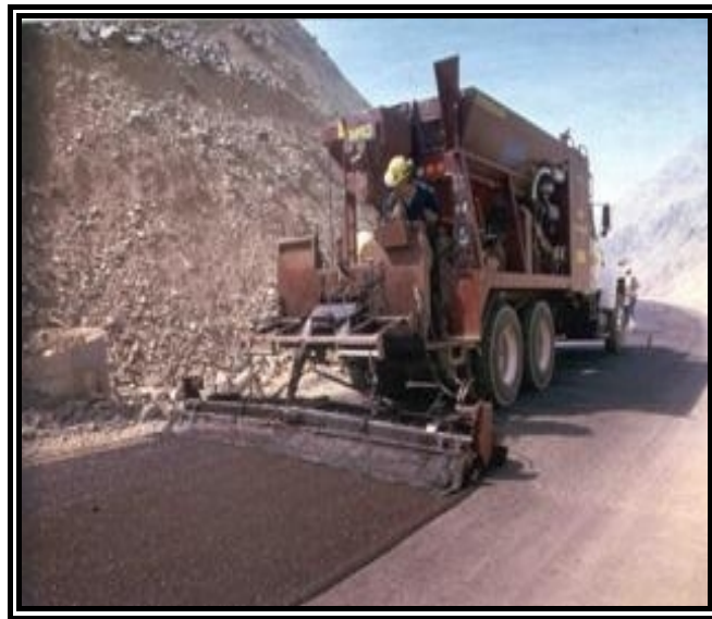
Cuadro N°3.21: Conformación de la Capa de Rodadura
