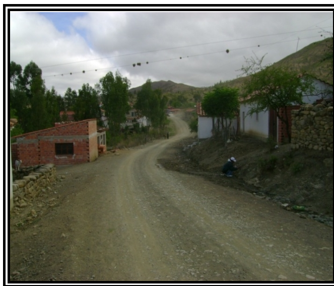
Figura N°3.10 Colocado de Estacas
