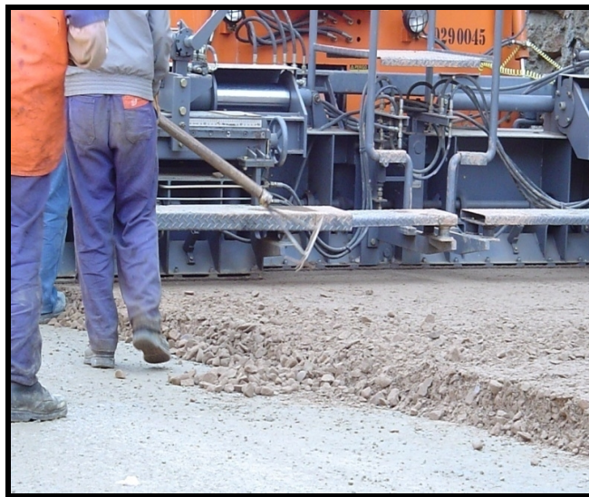
Figura N°3.20: Conformación de la Capa Base
