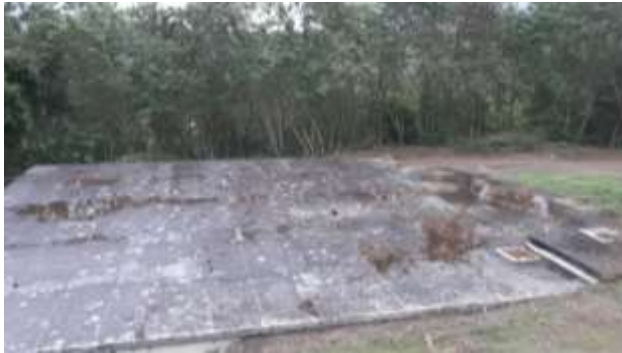
Figura 3. 21 Tanques de almacenamiento
