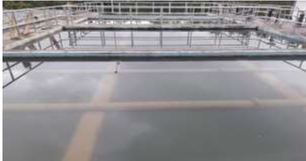
Figura 3. 18 Sedimentadores
