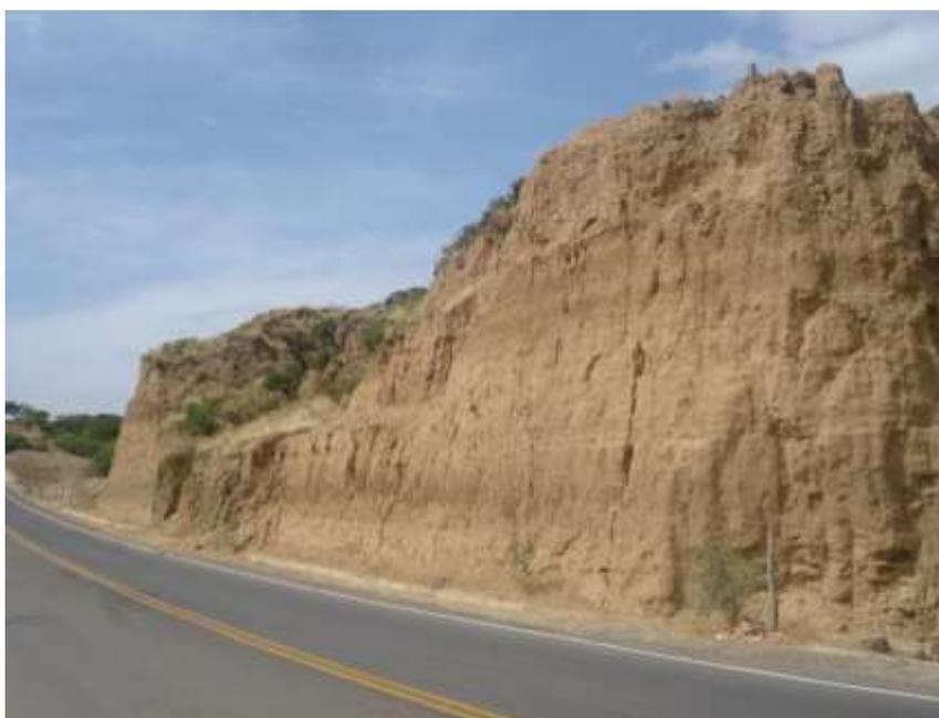
Fotografía 3.3: Talud erosionado con acumulación de material en el pie.
