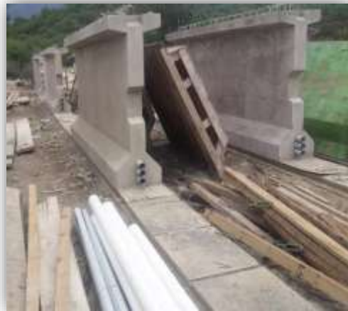
Para el lanzado de vigas por
