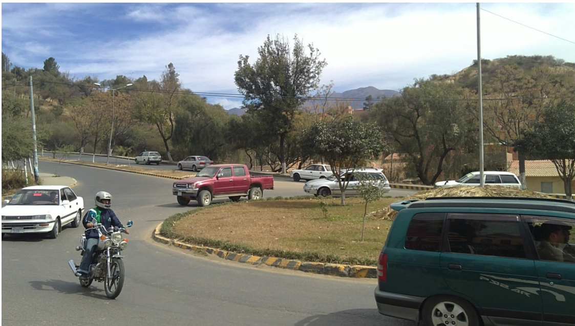
Figura 3.29. Acceso A en la Rotonda Ubicada entre la Av. Héroes de la Independencia y Av. Los Sauces
