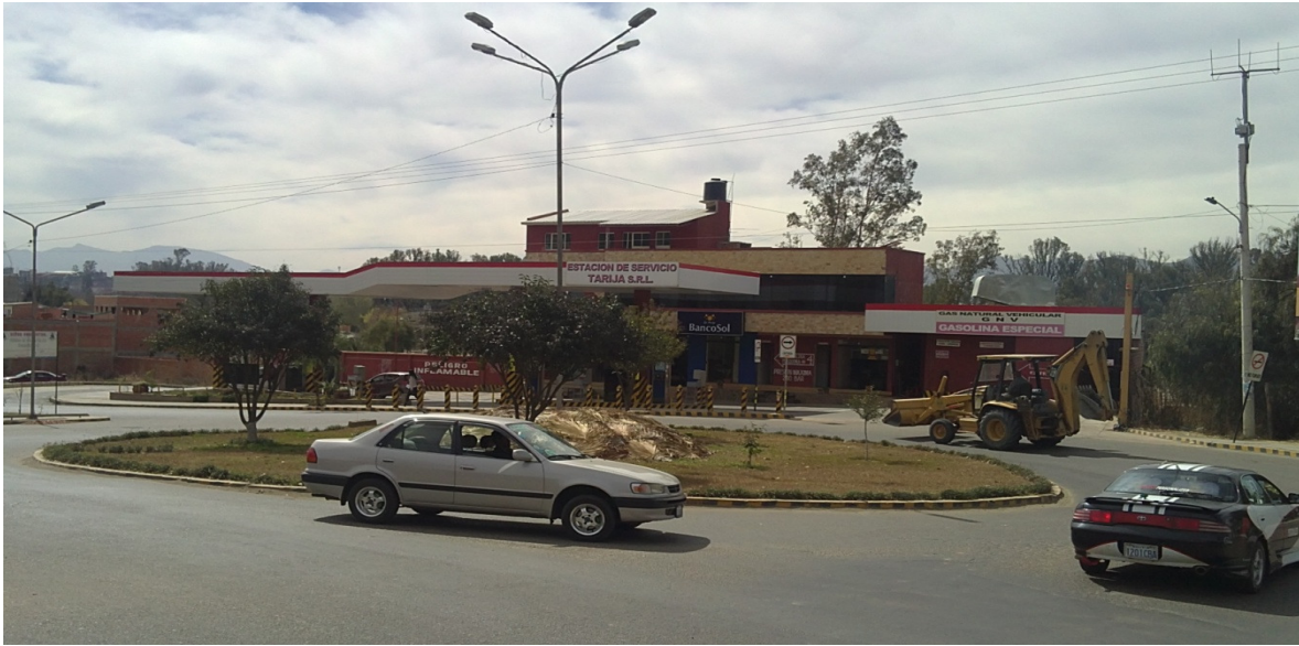
Figura 3.34. Calzada Anular en la Rotonda ubicada entre la Av. Héroes de la Independencia y Av. Los Sauces
