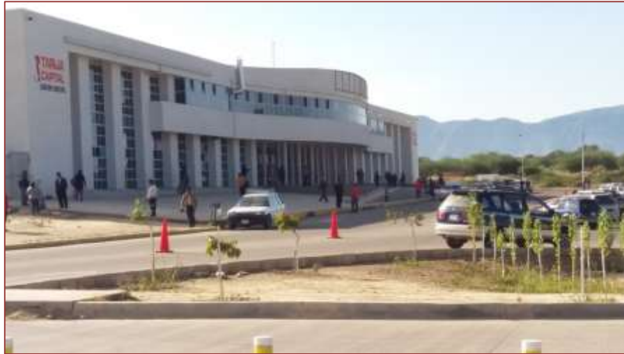
Fig.4.4 Frontis de la Nueva Terminal
