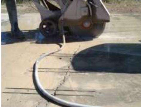
Imagen 3.23 Cortado de Hormigón (Equipo Importado)
