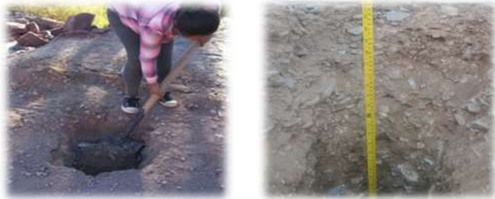
Gráfico 32. Imagen de verificación de espesores de carpeta estructural
