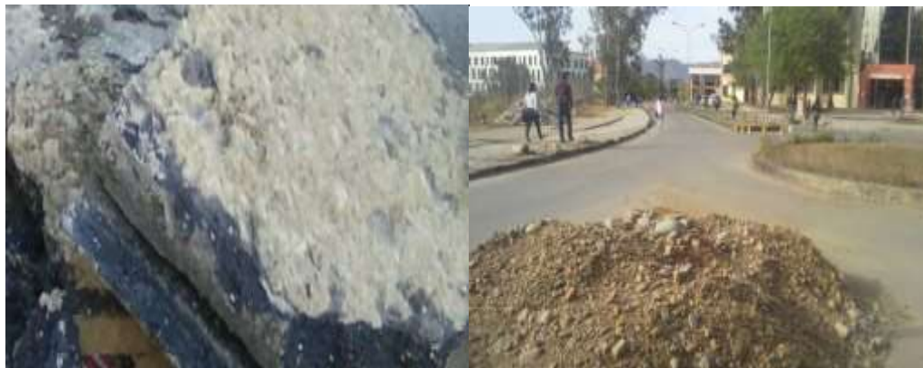
Figura 28. Extracción Muestra 3 Campus Universitario de la U.A.J.M.S.
