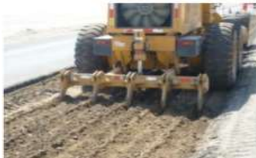
Figura 12. Escarificación De Material De La Sub-Base Granular
