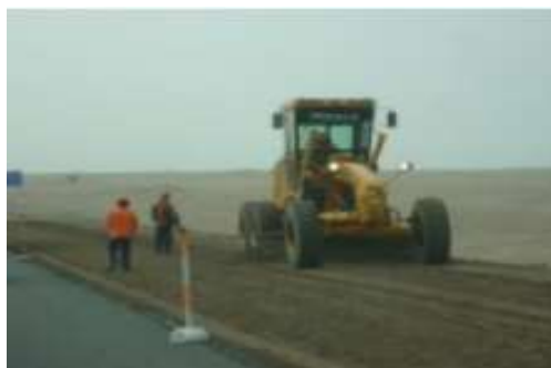
Figura 13. Conformación De Material De La Sub- Base
