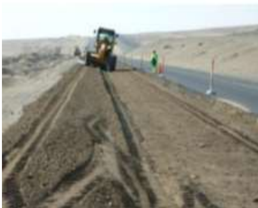
Figura 10. Extendido De Material De La Sub-Base
