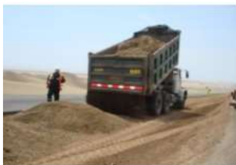
Figura 9. Colocación Del Material De Sub-Base Granular
