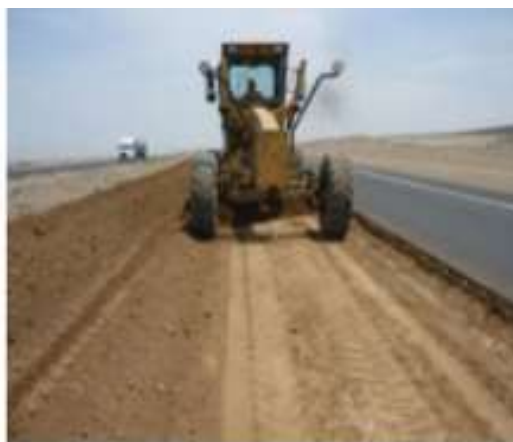
Figura 11. Batido De Material De La Sub-base Granular
