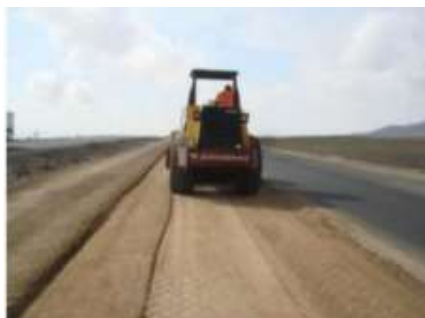
Figura 14. Compactación De Los Materiales De La Sub-Base Granular
