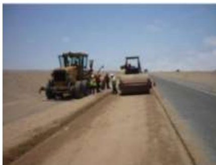
Figura 15. Terminación Del Material De La Sub- Base Granular
