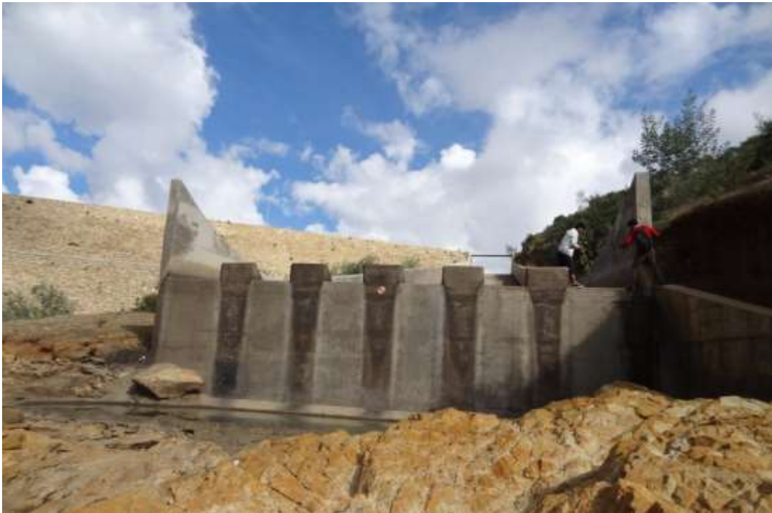
Figura 3.12. Salto sky presa Calderas
