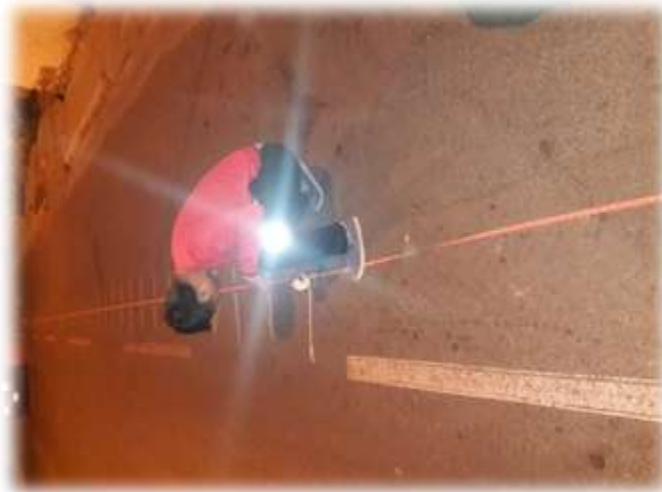
FIGURA 41. Marcado del pavimento a cada 500 mm.
