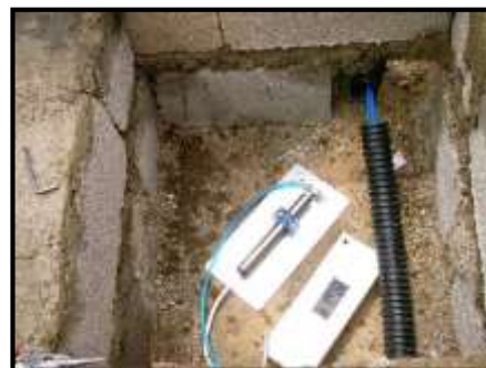
Figura 1.13. Instalación celda de asentamiento
