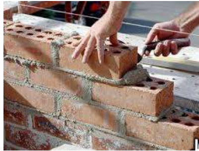
Figura 2.8 Mortero de albañilería para pircado de muros de ladrillo
