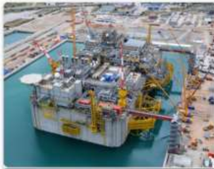
Figura 2.6 Adriatic LNG Terminal (obra construida con cemento portland con
