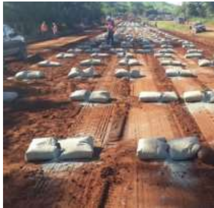
Figura 2.10 Estabilización con Cemento
