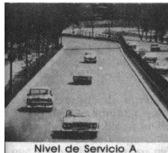
Figura N° 1 Ejemplo de Nivel de Servicio A
