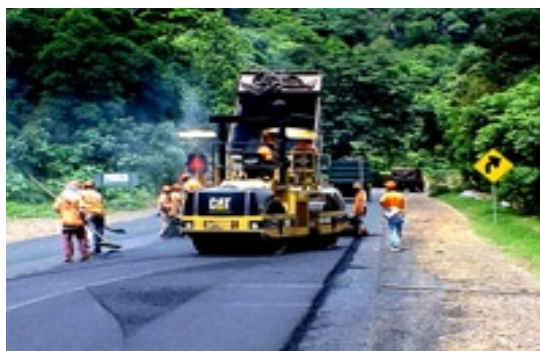
Figura 2.39 Construcción de nuevo pavimento
