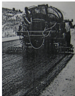
Figura 3.23 Aplicando un sello de lechada a la superficie
