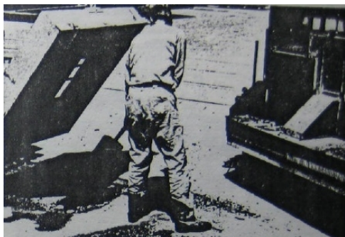
Figura 3.46 Llenando el hueco con mezcla almacenada
