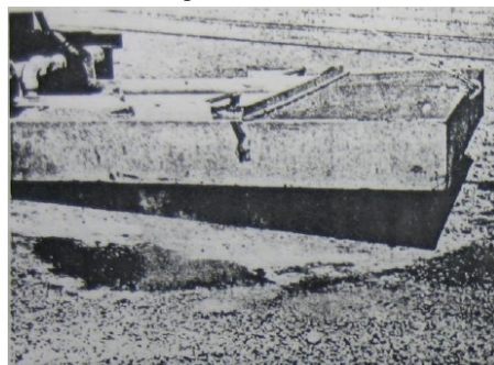
Figura 3.48 Secando el parche con el calentador infrarrojo
