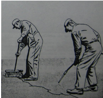
Figura 3.27 Limpiando la grieta con cepillo y aire comprimido
