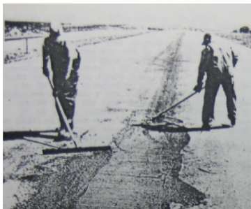
Figura 3.22 Llenando las grietas de encogimiento con sello de lechada
