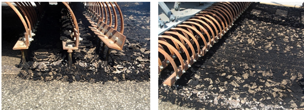
Figura 2.38 Escarificado del pavimento a reciclar
