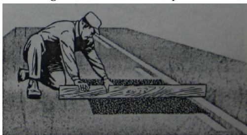
Figura 3.35 Nivelando el parche
