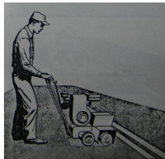
Figura 3.34 Aplicando la capa de pega
