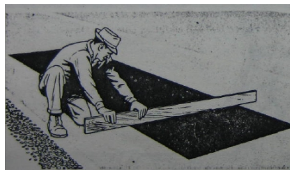
Figura 3.9 Nivelando el parche
