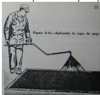
Figura 3.14 Aplicando la capa de pega
