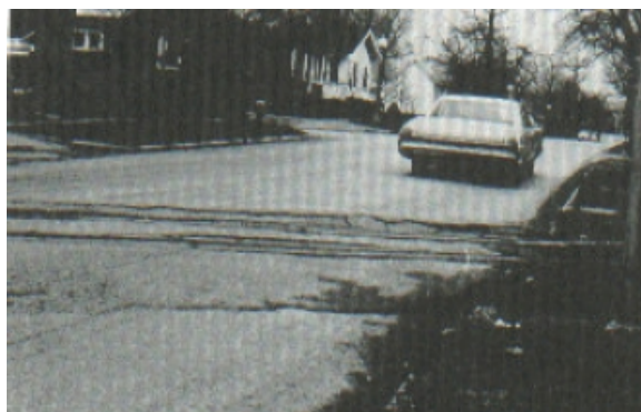
Figura 2.22 Cruce de vía férrea de alta severidad
