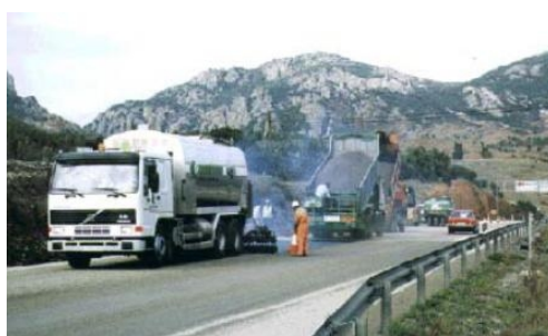
Figura 2.35 Refuerzo sobre el pavimento
