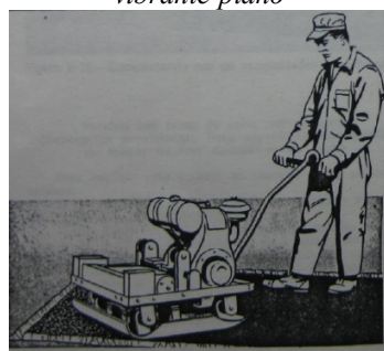
Figura 3.15 Colocando el parche delgado de mezcla en planta en caliente
