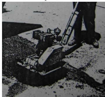
Figura 3.47 Usando el compactador vibrante plano
