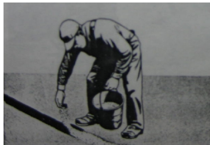
Figura 3.29 Recubriendo la superficie con arena seca
