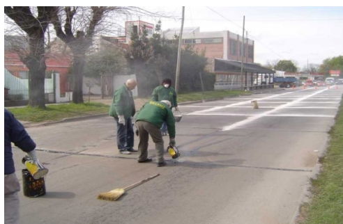
Figura 2.34 Mantenimiento de pavimento
