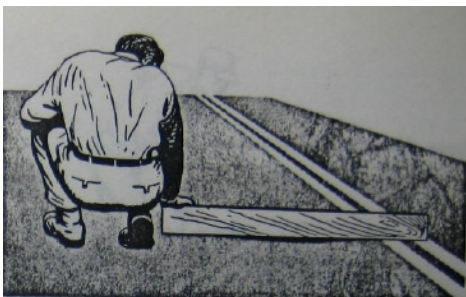
Figura 3.31 Demarcando y señalando un hundimiento
