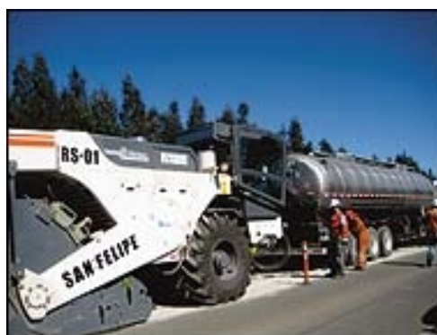
Figura 2.37 Reciclado Superficial del pavimento
