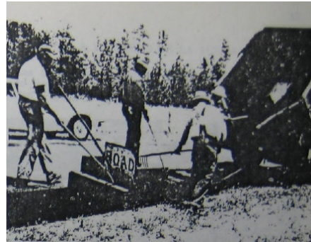
Figura 3.25 Extendiendo el material asfáltico mezclado en planta en caliente sobre un borde asentado
