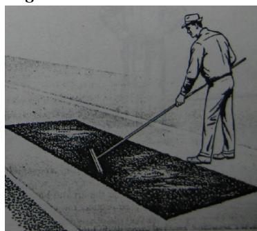
Figura 3.7 Extendiendo la mezcla
