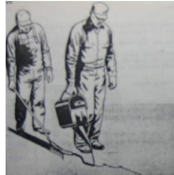
Figura 3.28 Sellando con una regadera y una maestra de mano
