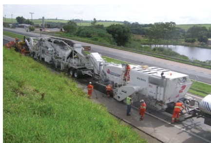
Figura 2.36 Reciclado del pavimento
