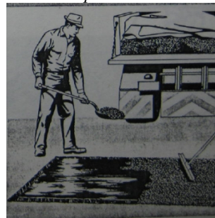
Figura 3.15 Colocando el parche delgado de mezcla en planta en caliente
