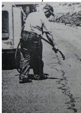
Figura 3.20 Limpiando grietas de encogimiento con aire comprimido
