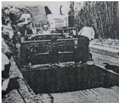
Figura 3.40 Extendiendo mezcla en planta densamente gradada
