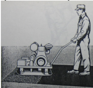
Figura 3.16 Compactando con un compactador vibrante-plano
