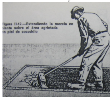
Figura 3.11 Extendiendo la mezcla en planta sobre el área afectada
