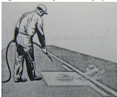
Figura 3.33 Limpiando la superficie
