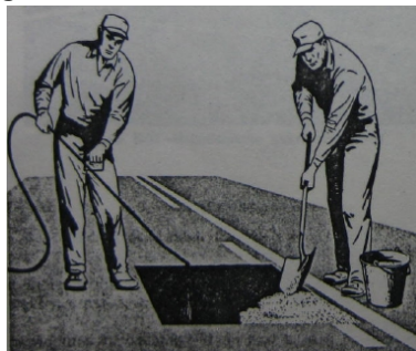
Figura 3.37 Colocando el sello de arena
