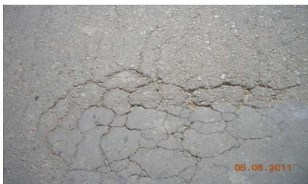
Figura 2.7 Nivel alto de piel de cocodrilo
