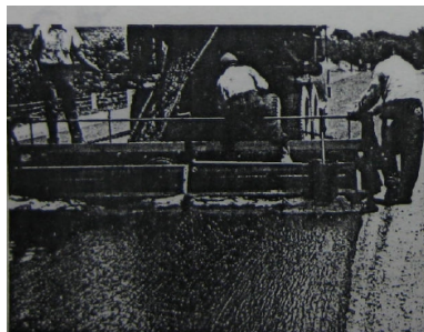
Figura 3.23 Aplicando un sello de lechada a la superficie
