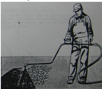
Figura 3.17 Regando asfalto sobre las grietas en piel de cocodrilo
