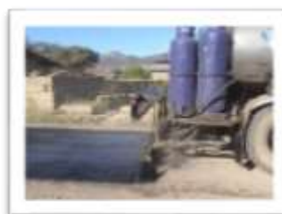
Fig. 2.7.2.2 – Aplicación De Asfalto
