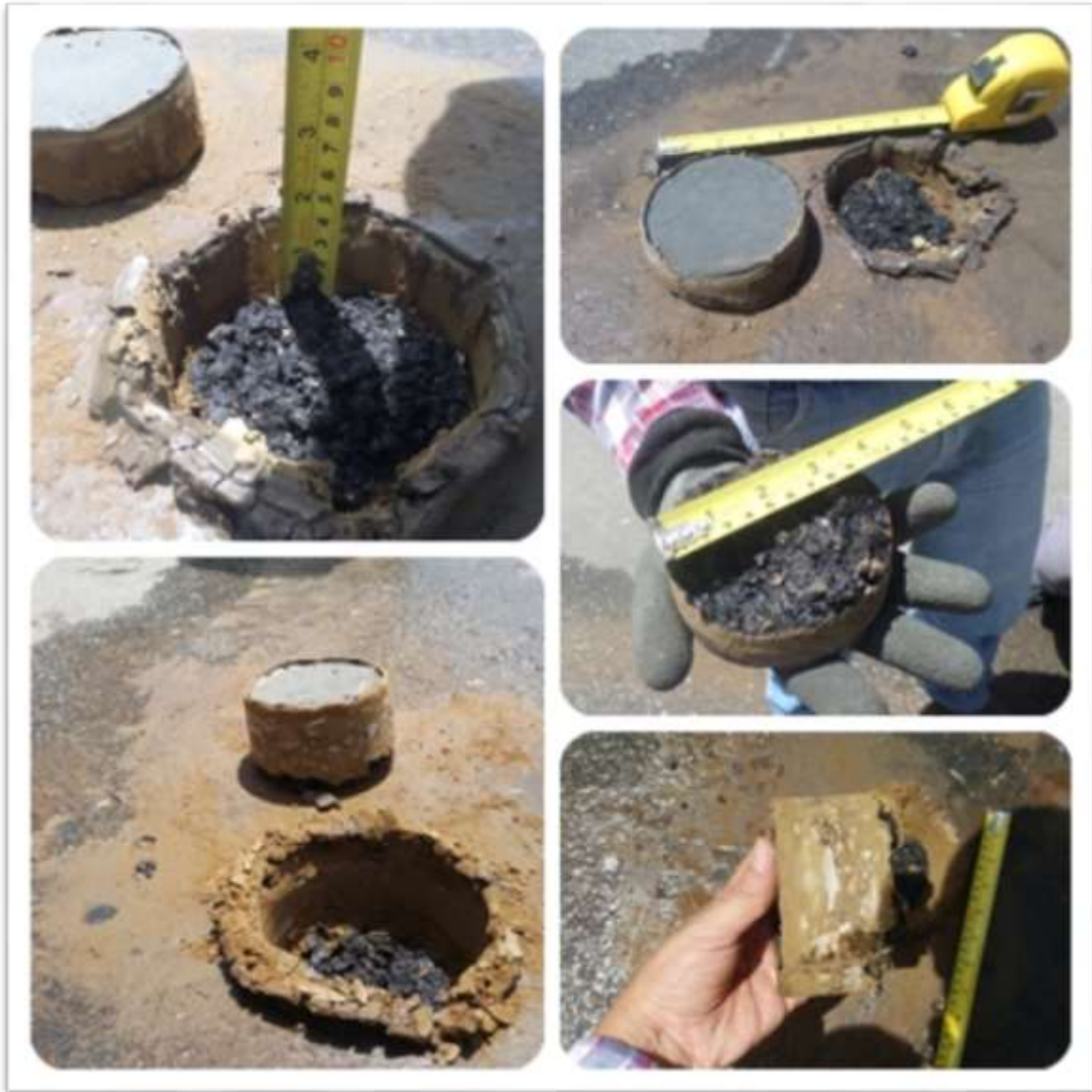
Fig. 3.4.2.2. Extracción De Los Núcleos Del Tipo Exudación Con Altos Contenido De Asfalto
