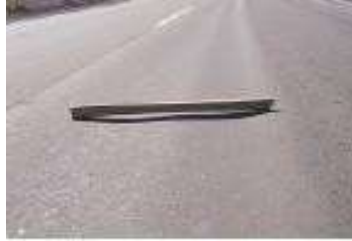
Fig. 2.5.1.2.3 - Ahuellamiento
