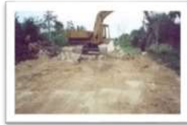
Fig. 2.7.1 - Proceso De Construcción
