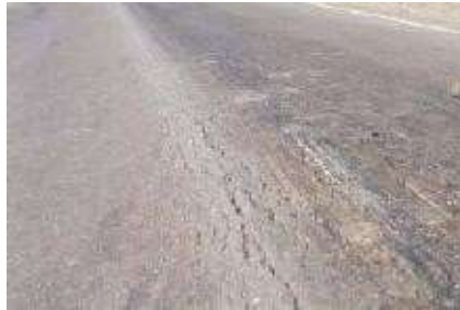
Fig. 2.5.1.2.4 – Deformación Transversal
