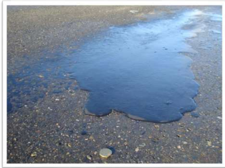
Fig. 3.4.1.1.3. Detalle de sector con exudación
