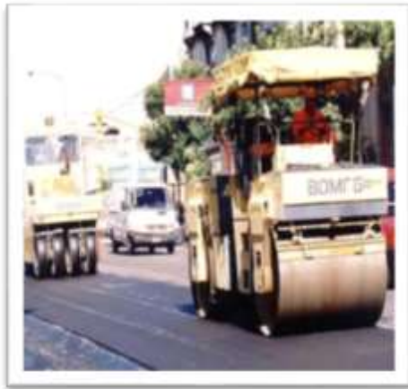
Fig. 2.7.4 – Compactadoras Neumáticas
