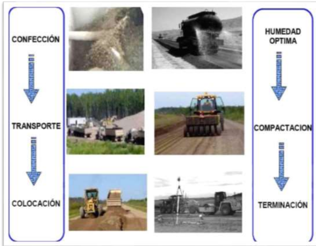
Fig. 2.2.1 – Proceso De Construcción Pavimento Flexible
