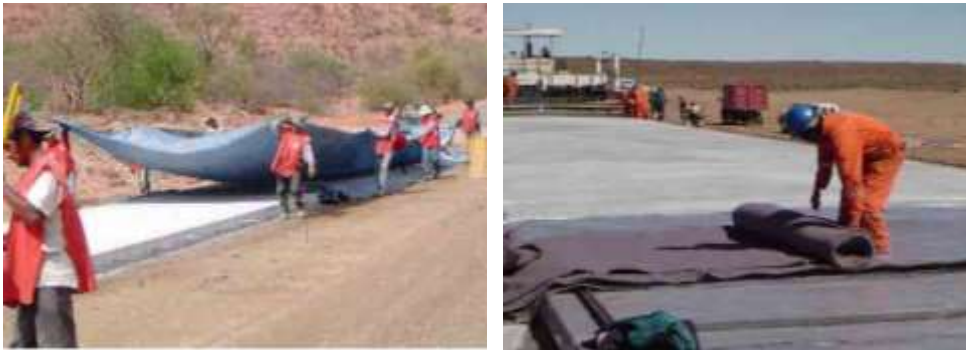
Fig. 2.10: Detalle de mantas para el curado
