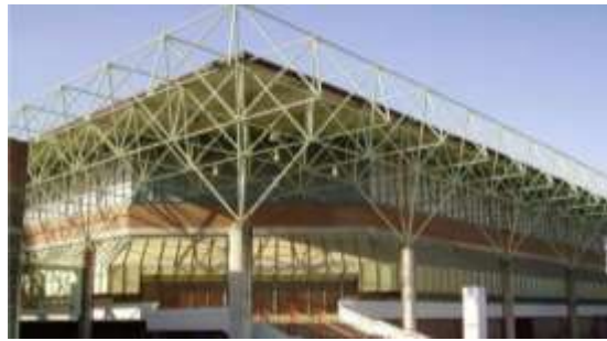
Figura 6. Cubierta esterea del Pabellón de deportes de San Pablo, Sevilla
