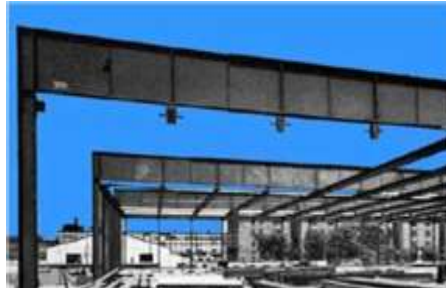
Figura 4. Pórticos planos del Crown Hall de Chicago.
