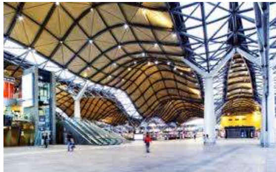
Figura 17. Las cúpulas de la estación de Melbourne vistas desde abajo.
