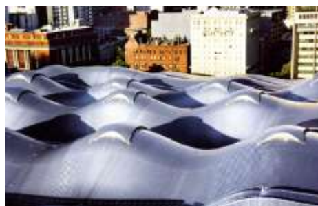
Figura 16. Vista aérea de la cobertura de Southern Cross Station, Melbourne, con las cúpulas de doble curvatura, con láminas de aluminio cincado.
