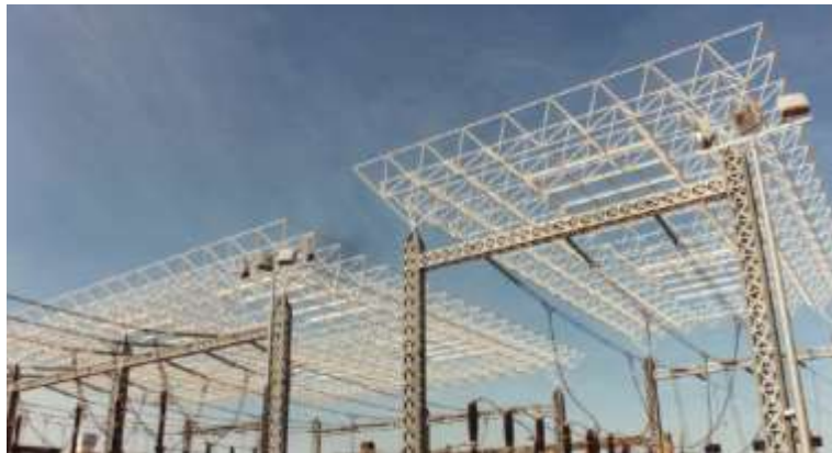
Figura 54. Techos de estereoestructura
