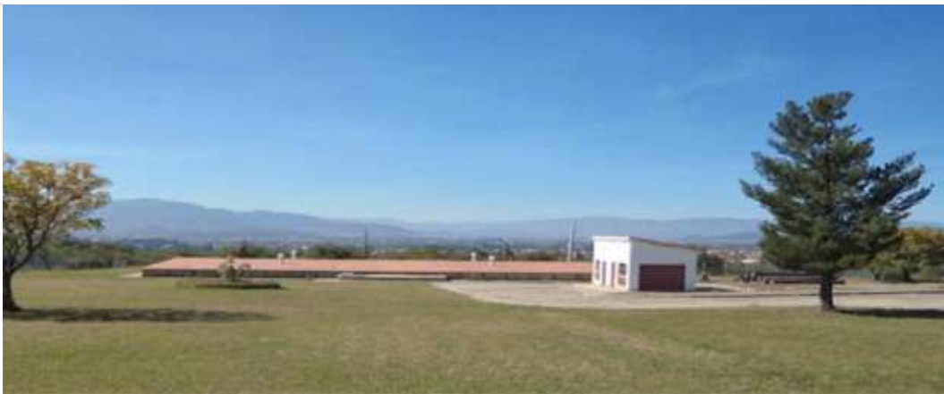
Fotografía 2.10 Tanques de almacenamiento
