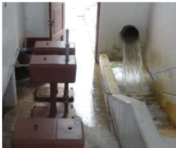
Fotografía 2.5 Mezcla rápida
