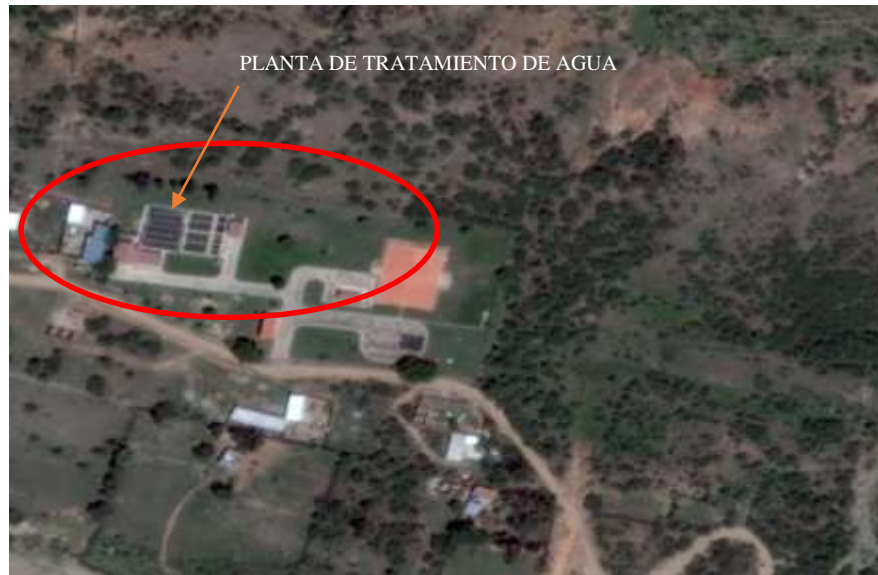
Figura 1.1 Instalación de la planta de tratamiento Tabladita
