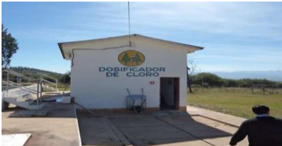
Fotografía 2.9 Casa de desinfección
