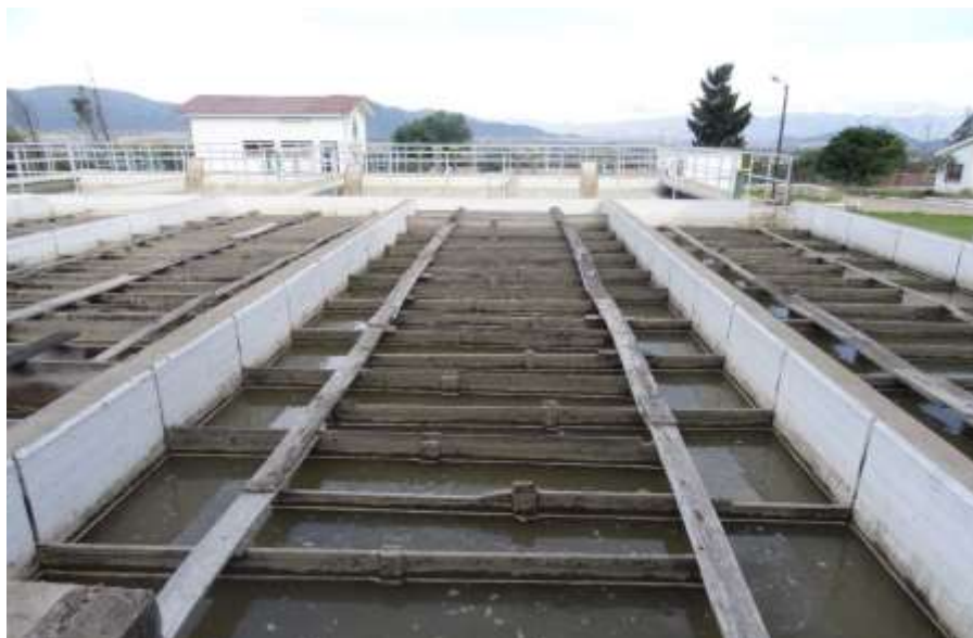
Fotografía 2.6 Unidad de floculación
