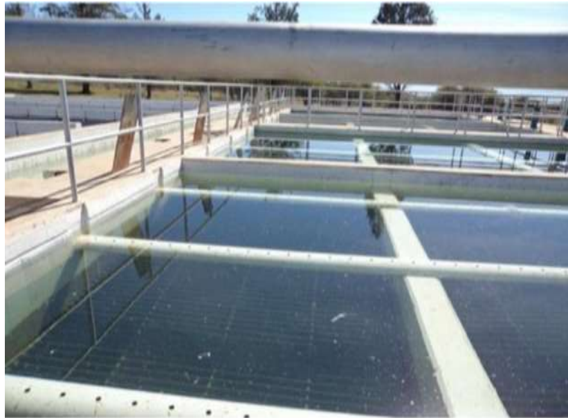
Fotografía 2.7 Unidad de sedimentación
