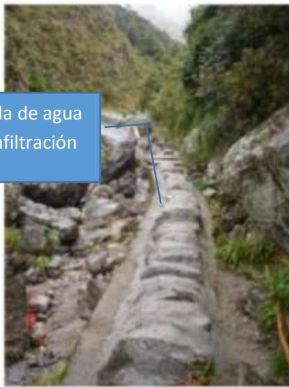
Fotografía 2.2 canal de aducción
