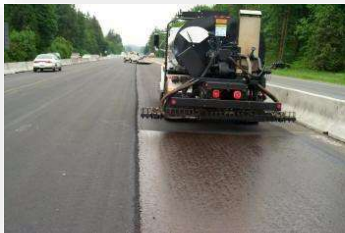
Figura 2.6 Riego De Liga Uniforme
