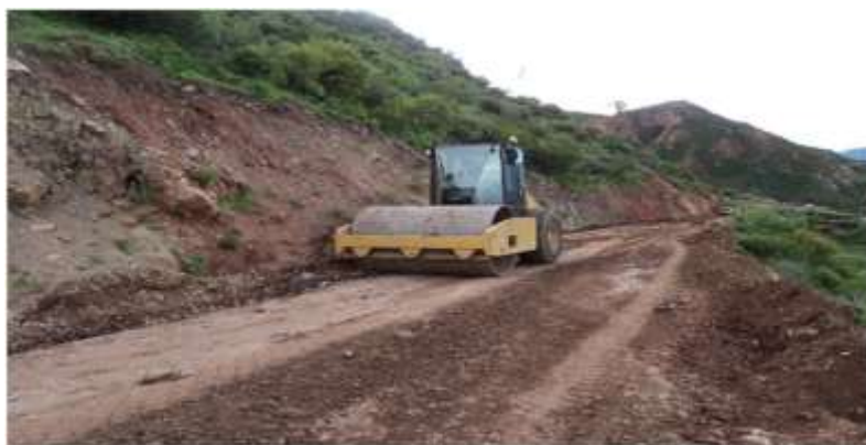
FIGURA 2. 4: TRABAJO DE COMPACTADO DE SUB RASANTE
