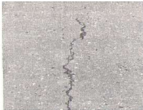
(Fisuras longitudinales)
