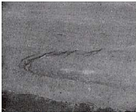
(Fisuras parabólicas "Lengüetas")
