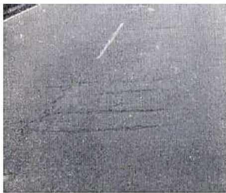
(Fisuras transversales)
