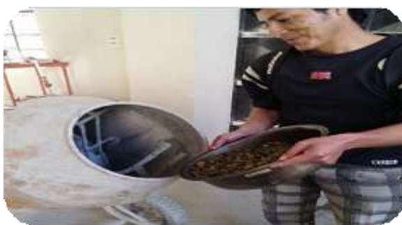
FOTOGRAFÍA 25. Mezclado de Hormigón
