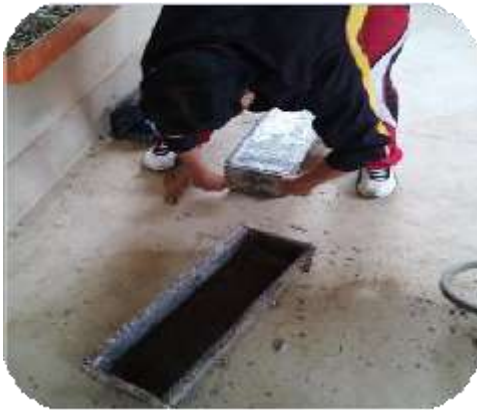
FOTOGRAFÍA 29. Desmolde de Vigas
