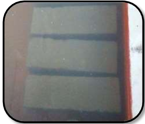
FOTOGRAFÍA 30. Curado de Vigas
