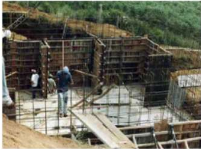
FIGURA 3. 22: Estructura de concreto.
