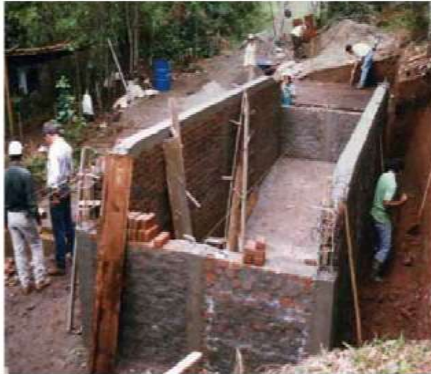
FIGURA 3. 20: Estructura de mampostería.
