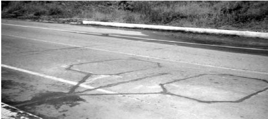
Figura 13: Sensores Piezo-eléctricos adheridos sobre el pavimento
