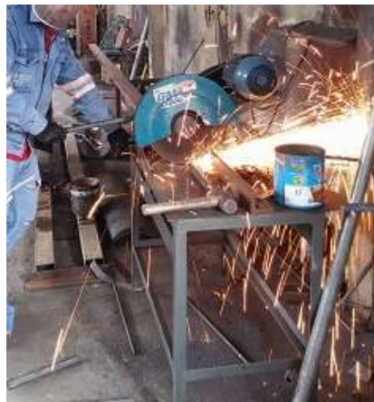
FOTO N° 8, Cortado de Barras (Dovelas)
