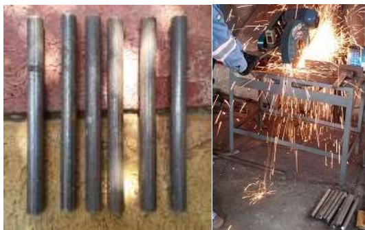
Foto N° 9, Dovelas Lisas de 1 Pulgada.
