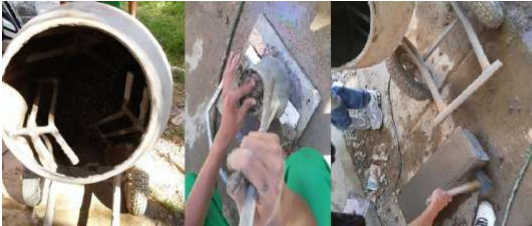
Foto N° 14, Mezclado y Vaciado de Moldes con Hormigón
