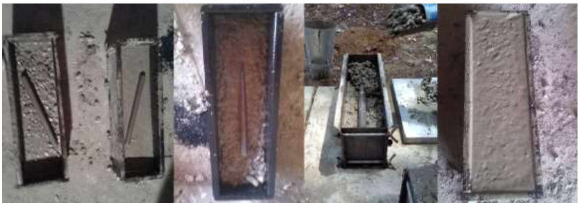
Foto N° 15, Colocado de Barras (dovelas) en los Moldes
