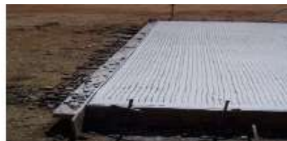
FOTO N° 3, Junta de Construcción en Pavimento Rígido.
