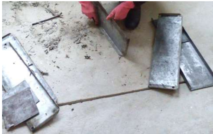
Foto N° 20, Limpieza de Moldes.
