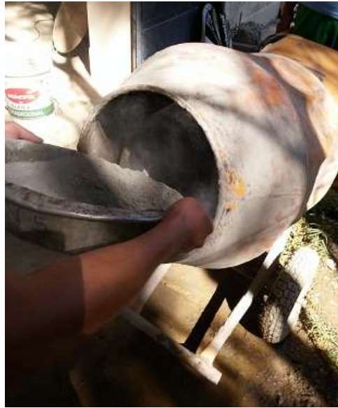
Foto N° 12, Mezcla de Hormigón mediante Dosificación Calculada.
