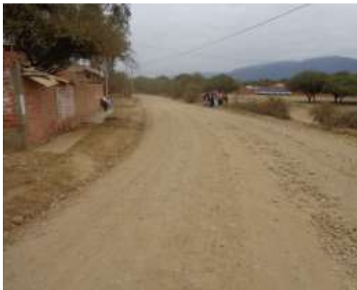
Calle El Rodeo(Inicio del ripiado)
