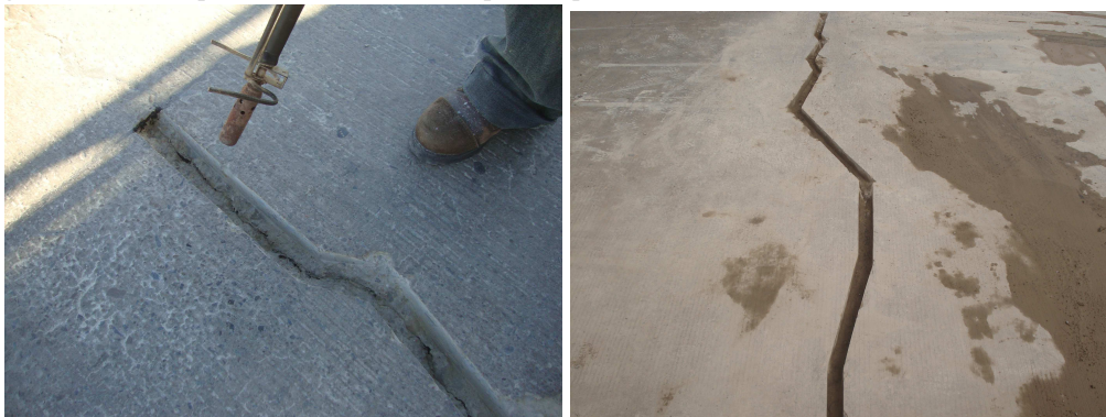
Figura IV- 46: Limpieza de la Grieta Calada para su posterior Sellado
