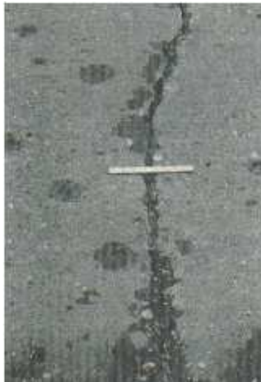
Figura II-18: Grietas lineales de alta severidad en losa de concreto simple.
