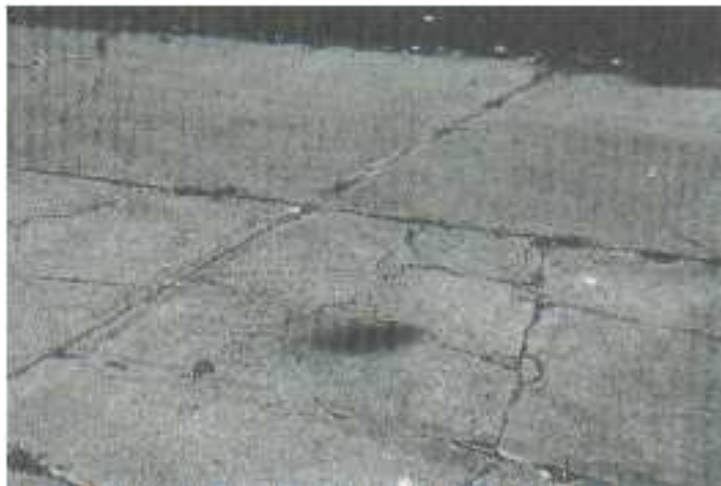
Figura II- 24: Losa dividida de alta severidad.
