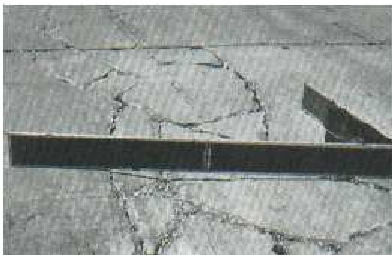
Figura II- 60: Punzonamiento de alta severidad.
