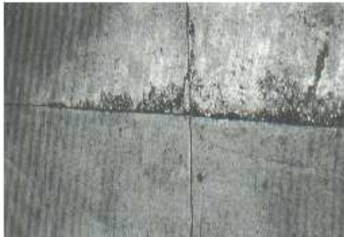
Figura II- 30: Descascaramiento de junta de alta severidad.
