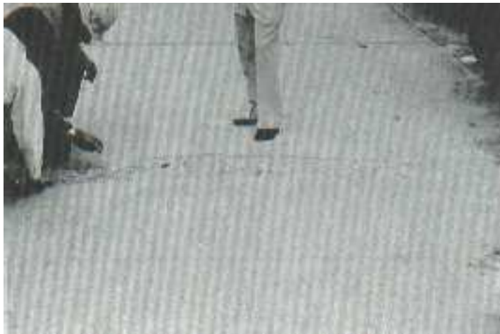
Figura II- 56: Grieta de durabilidad de alta severidad.
