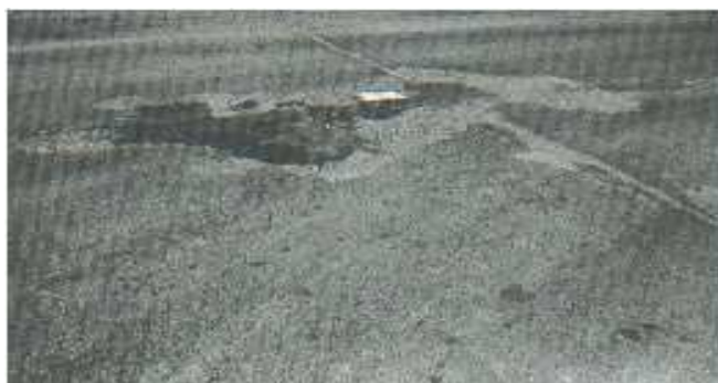
Figura II- 33: Desconchamiento / Mapa de grietas / Craquelado de alta severidad.
