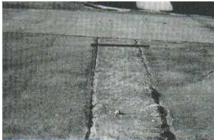
Figura II- 49: Parche grande y acometidas de servicios públicos de alta severidad.
