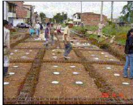
Figura II- 9: Vista típica del proceso constructivo de losas continuamente reforzadas
