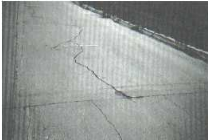
Figura II- 24: Losa dividida de alta severidad.
