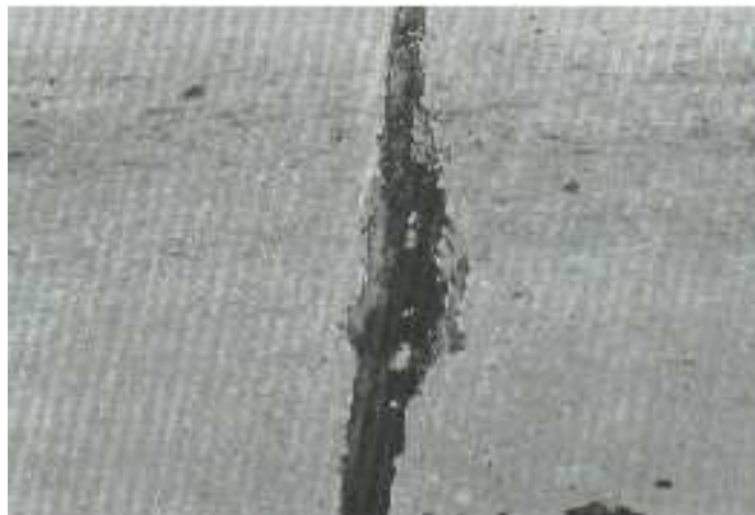
Figura II- 27: Daño del sello de junta de alta severidad.
