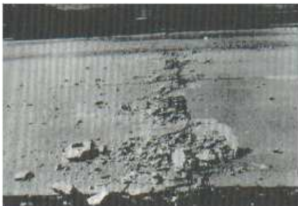
Figura II- 45: Blowup / Buckling de baja severidad.
