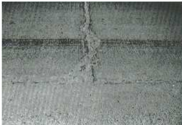
Figura II- 36: Descascaramiento de esquina de alta severidad.
