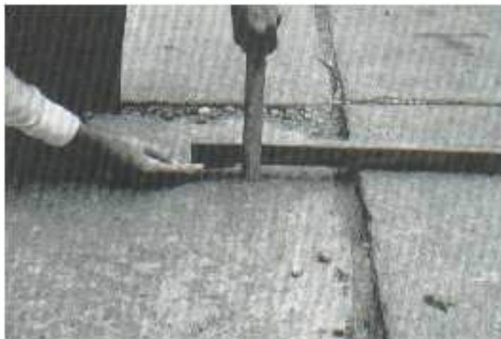
Figura II- 41: Escala de alta severidad.
