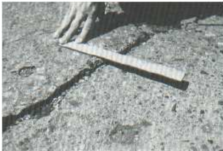
Figura II- 41: Escala de alta severidad.
