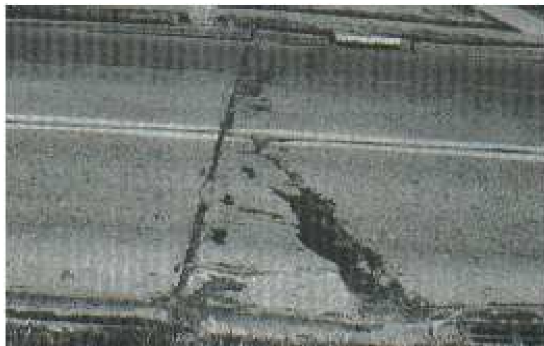
Figura II- 60: Punzonamiento de alta severidad.
