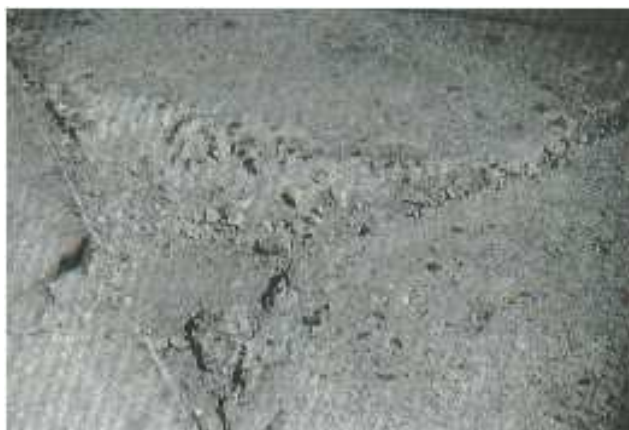
Figura II- 36: Descascaramiento de esquina de alta severidad.
