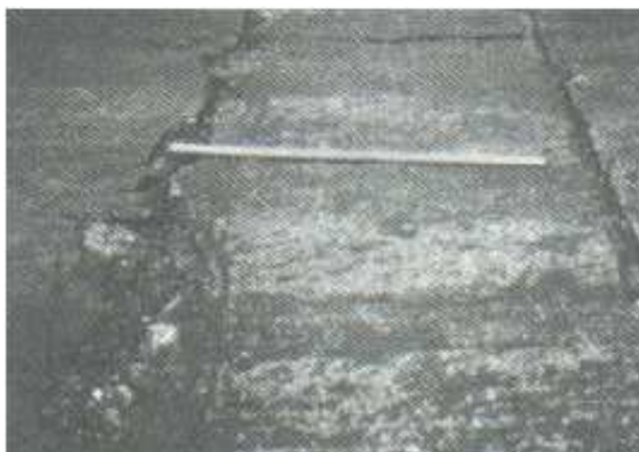
Figura II- 49: Parche grande y acometidas de servicios públicos de alta severidad.
