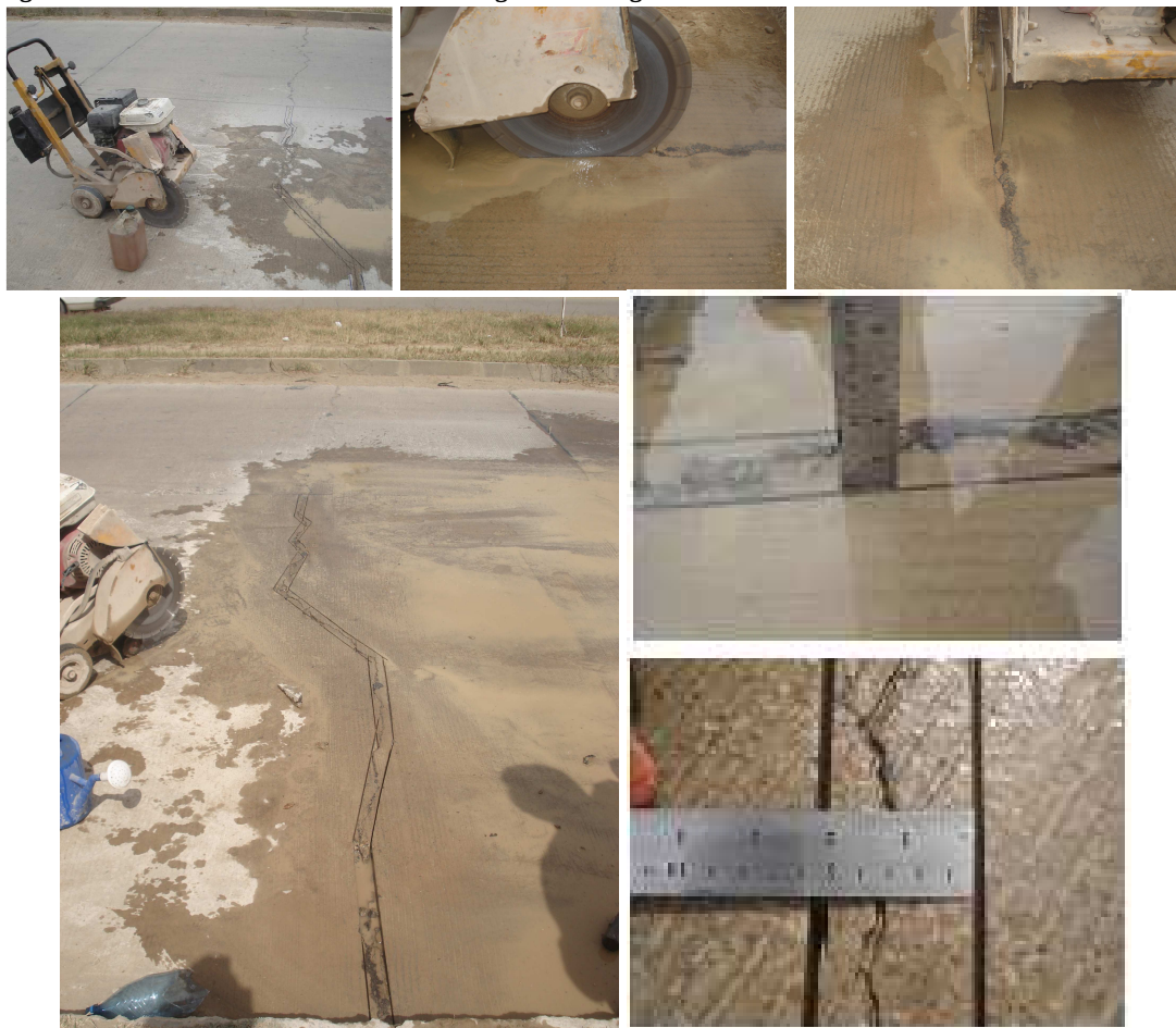
Figura IV- 44: Corte de la Losa delimitada según la Configuración
