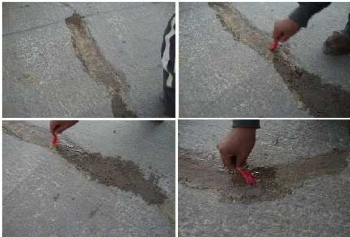
Figura IV- 54: Pintado con Resina para ayudar a la impermeabilización y el deterioro superficial.
