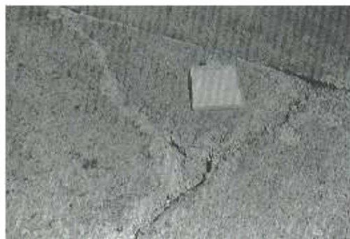
Figura II- 14: Grieta de esquina de alta severidad.
