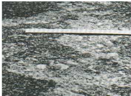
Figura II- 33: Desconchamiento / Mapa de grietas / Craquelado de alta severidad.
