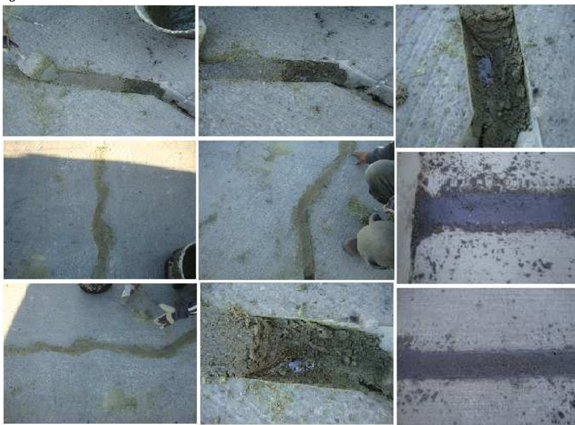
Figura IV- 53: Sellado de la Grieta
