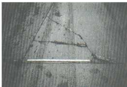
Figura II- 14: Grieta de esquina de alta severidad.
