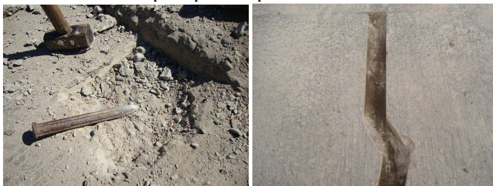
Figura IV- 45: Picado de la Losa para su posterior Reparación
