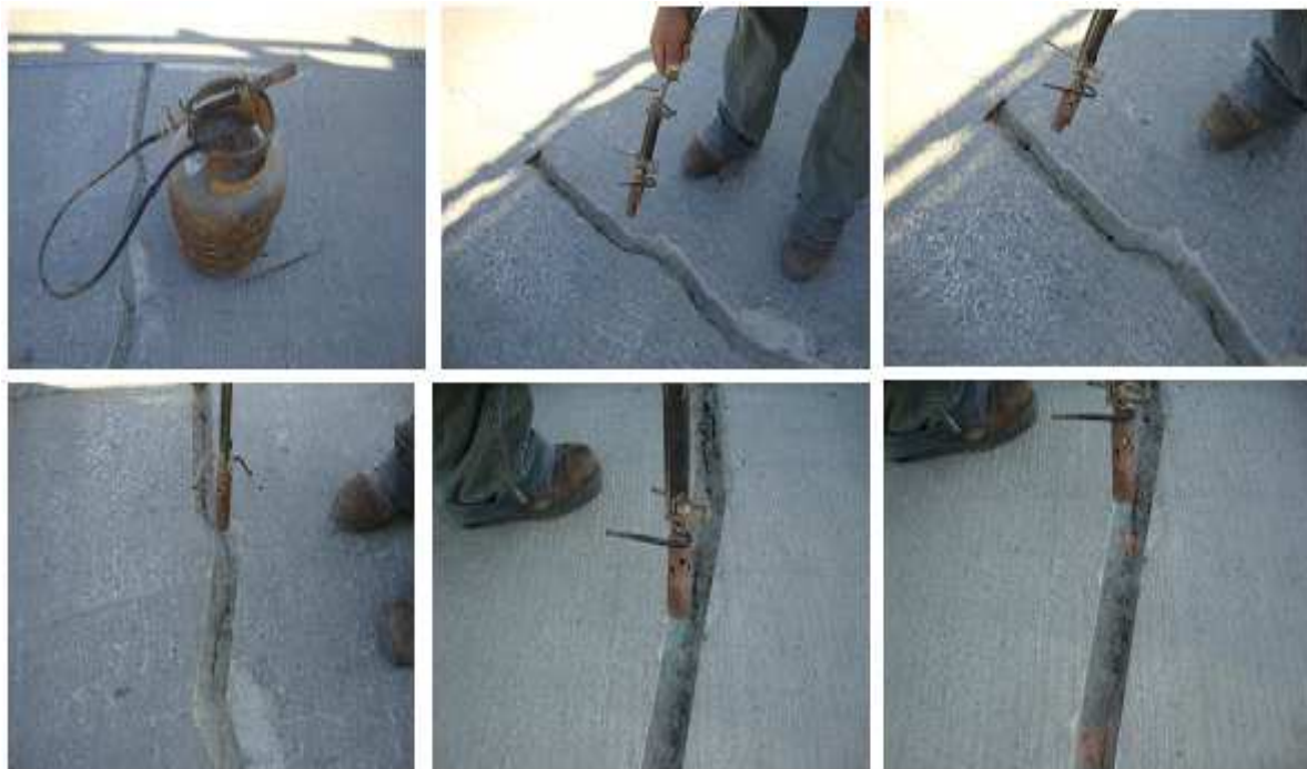
Figura IV- 52: Ruteado de la Sección a Sellar (grieta) con soplete
