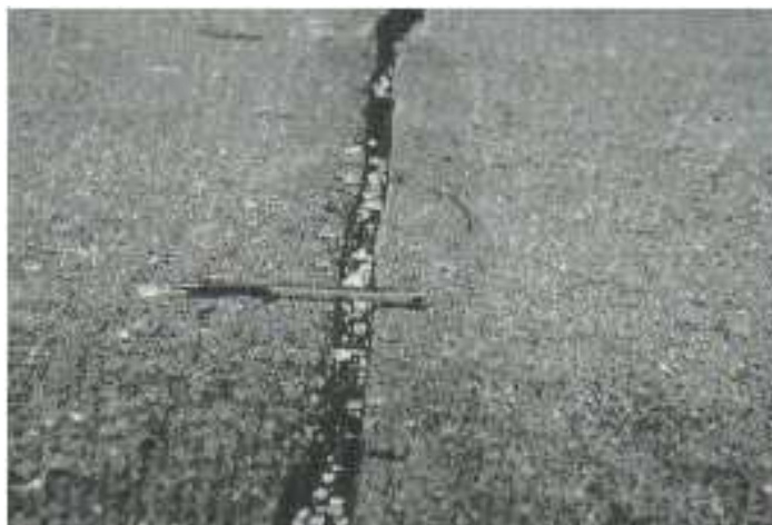
Figura II- 27: Daño del sello de junta de alta severidad.
