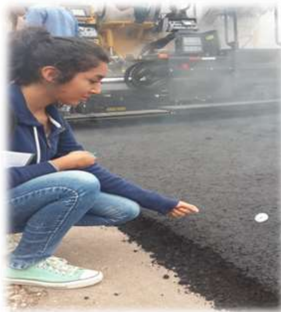
Figura 4.3 Medición de temperatura en plataforma
