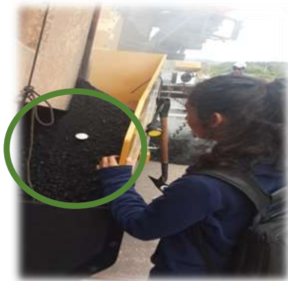
Figura 4.2 Medición de temperatura en la tolva de la terminadora
