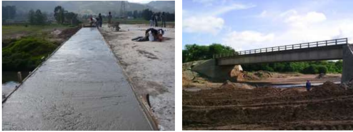
Fig. 4,28.- Ejecución de vereda y bordillo de H 0 A 0 , accesorios (barandado)
