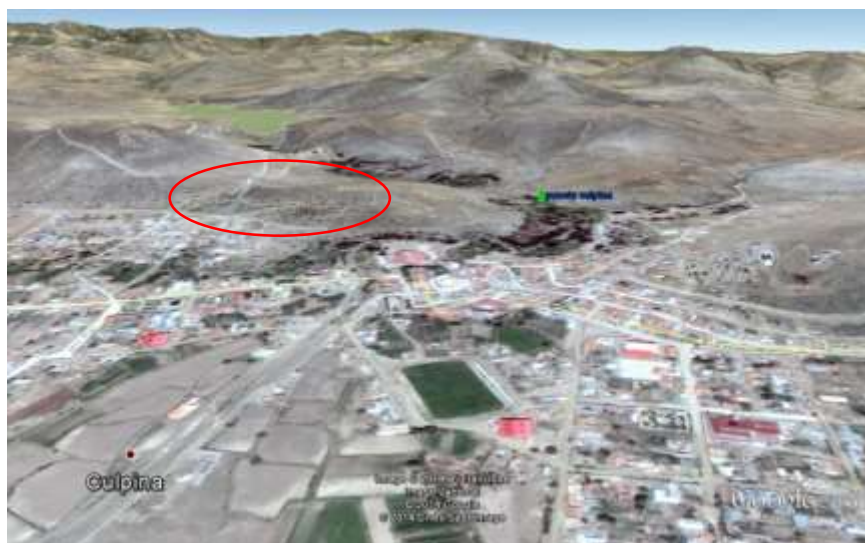
Fig.- 1.4.- Ubicación del puente distrito I Culpina, imagen satelital capturada desde Google Earth.
