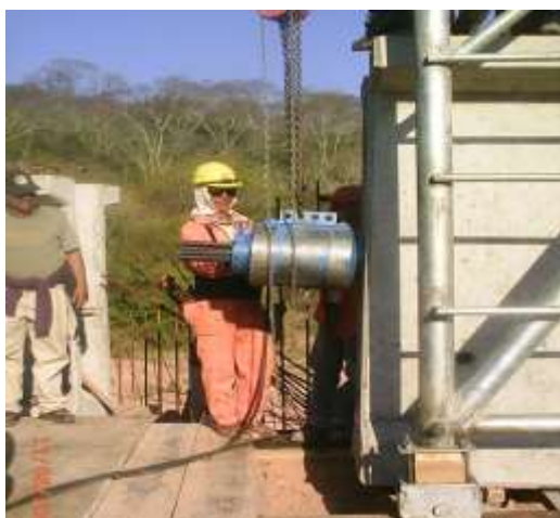
Fig.4.24.- Tesado de torones con gato hidráulico.
