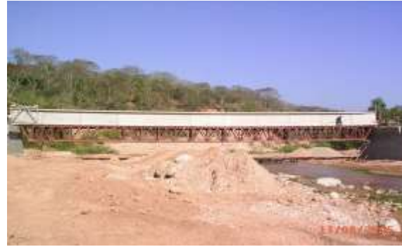
Fig. 4.22.- Lanzado de vigas de Ho Po. Sobre viga metálica apoyada pila a pila.
