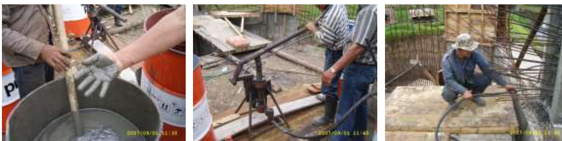
Fig.4.25.- Inyección de lechada.
