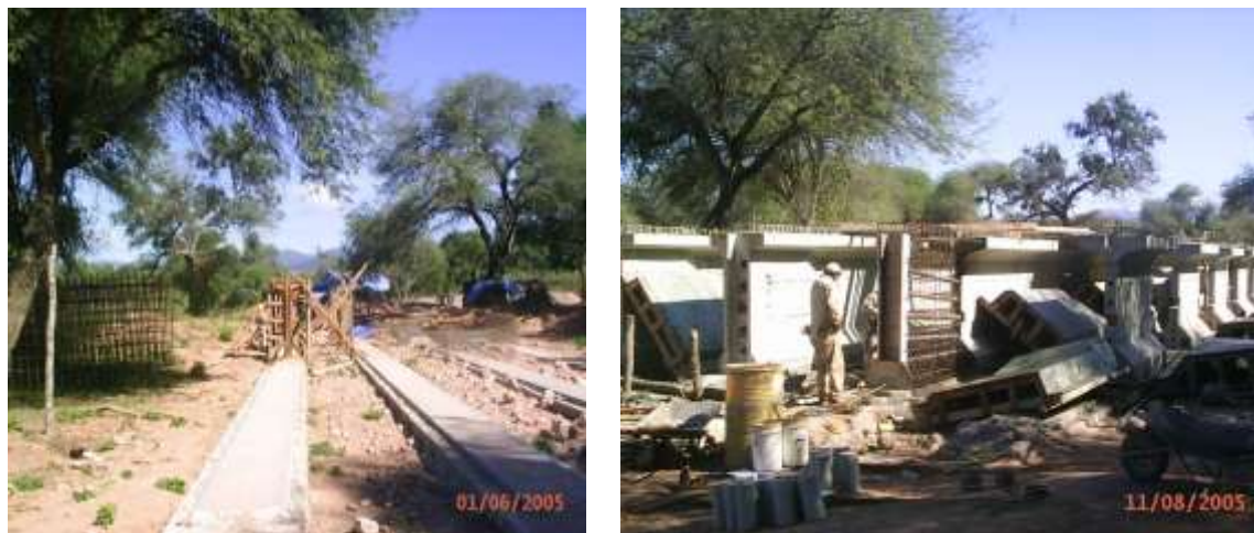
Fig. 4.19.- Construcción de vigas de hormigón postesado por segmentos
