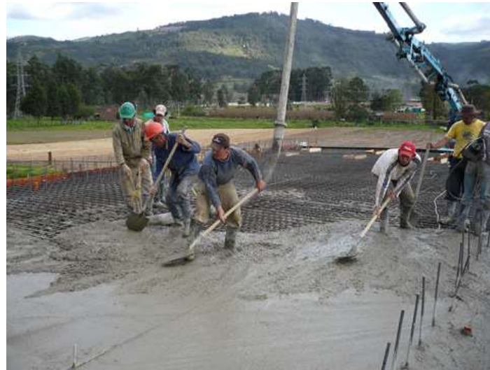
Fig.4.27.- Ejecución de losa del tablero de H 0 A 0
