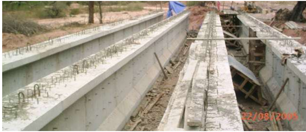
Fig. 4.20.- Construcción de vigas de hormigón postesado (viga completa)
