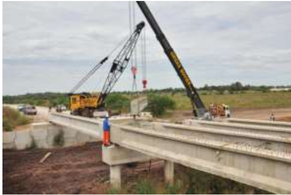
Fig. 4.23.- Posición final de vigas de Ho Po.
