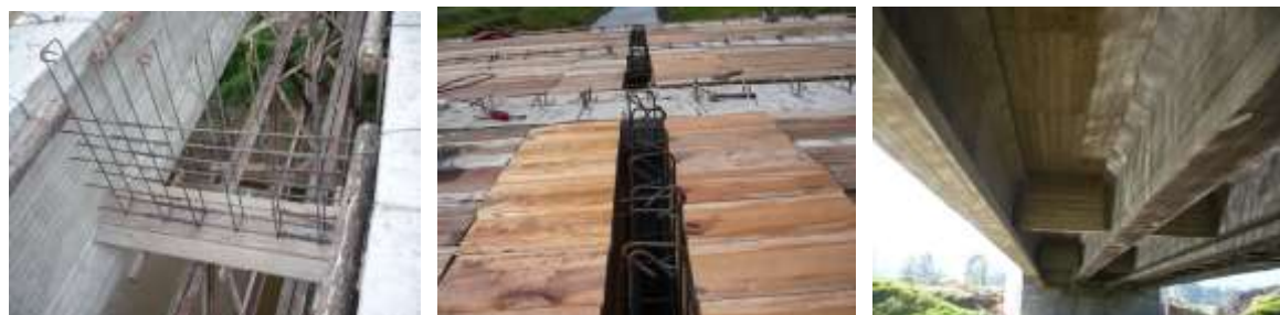
Fig.4.26.- Ejecución de las vigas diafragmas de H o A o
