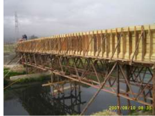
Fig. 4.23.- Posición final de vigas de Ho Po.
