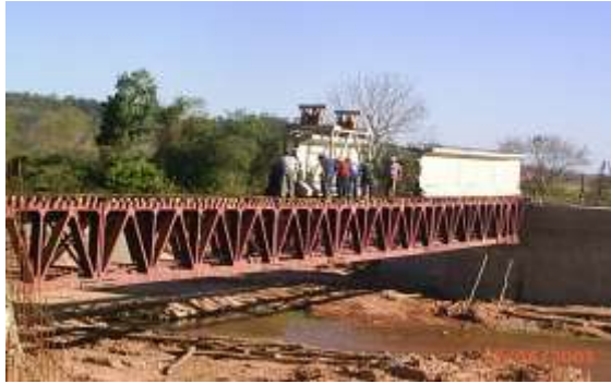
Fig. 4.22.- Lanzado de vigas de Ho Po. Sobre viga metálica apoyada pila a pila.
