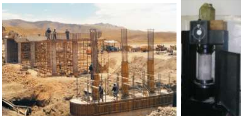
Fig.4.18.- Ejecución de pila central de H 0 A 0 , control de resistencia de probetas c/ que el supervisor lo requiera
