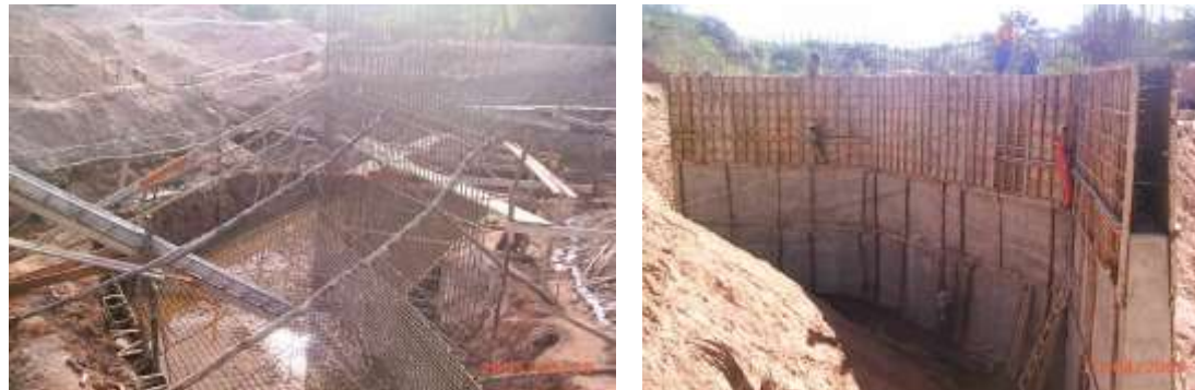
Fig.4.17.- Ejecución de estribo y aleros de H 0 A 0 .
