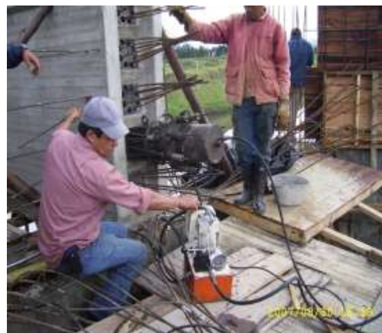
Fig.4.24.- Tesado de torones con gato hidráulico.
