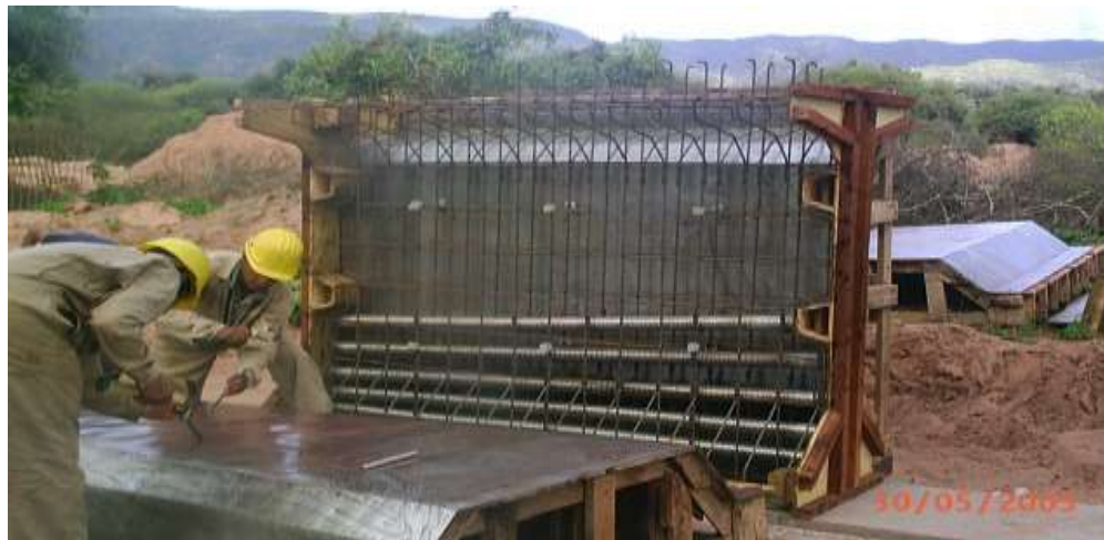
Fig. 4.21.- Colocado de Vainas de 10 torones Protende tipo MTC G260 0,6”
