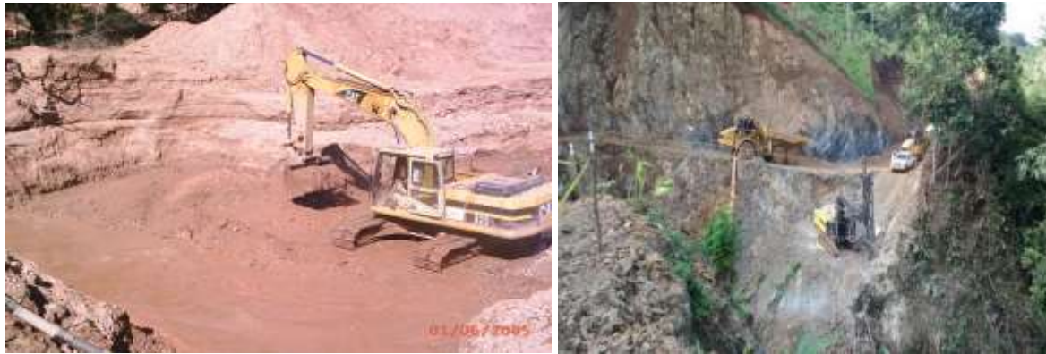
Fig. 4.16.-Excavación para fundaciones de estribos y pilas.
