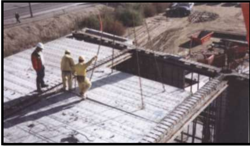
FIG N° 3.31 Montaje de losa
