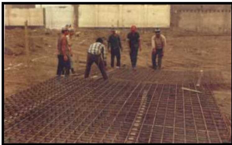
FIG N° 3.26 Armado de las Mallas superior e inferior
