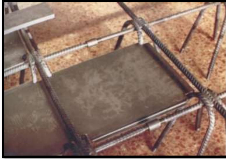
FIG N° 3.29 Pieza prefabricada colocada, para el vaciado de la carpeta de Hormigón
