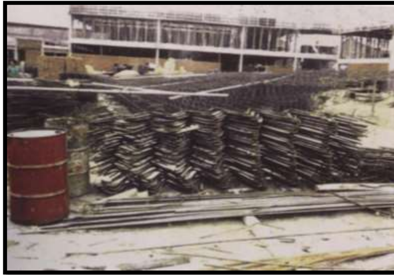
FIG N° 3.27 Doblado de las diagonales
