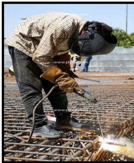
FIG N° 3.28 Unión de las Mallas y Diagonales mediante Soldadura
