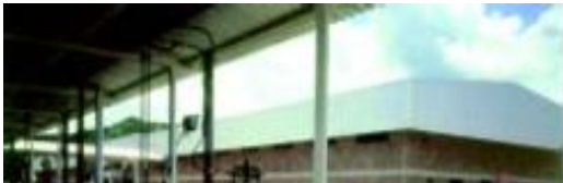
Figura 3.52 Batería de filtros de 1,0 m 3 /s de capacidad
