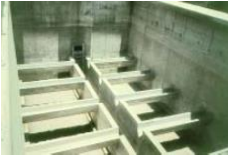
Figura 3.61. Canal principal central y canaletas secundarias laterales
