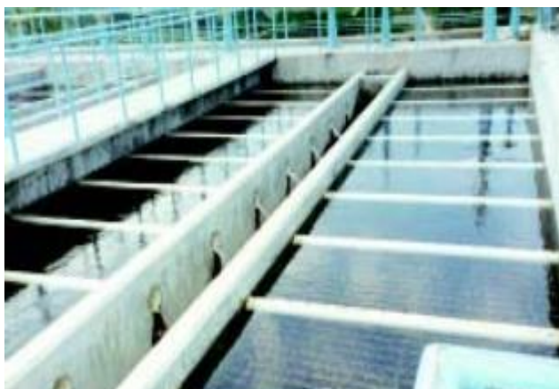
Figura 3.41 Sistema de recolección mediante tuberías perforadas
