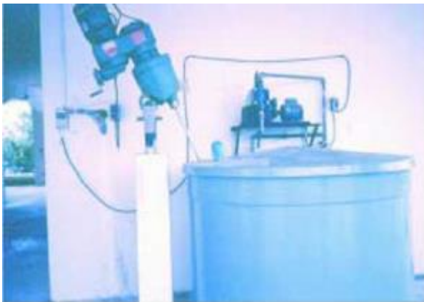
Figura 3.10 Sistema de dosificación por Bombeo
