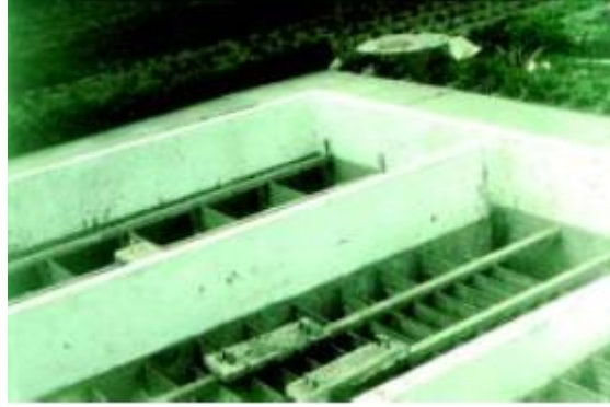
Figura 3.25. Floculador con pantallas de asbesto-cemento planas
