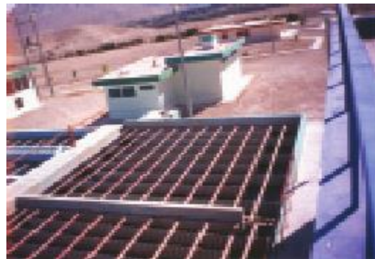
Figura 3.22 Floculador de pantallas de flujo horizontal
