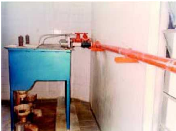
Figura 3.12 Dosificación de orificio carga constante
