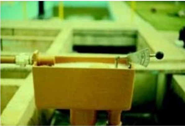
Figura 3.14 Dosificador por gravedad de orificio de carga constante
