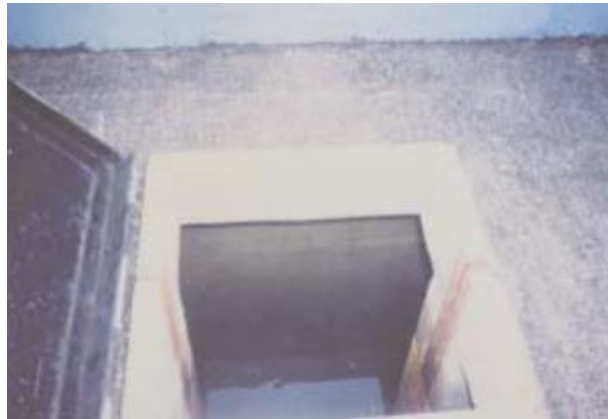
Figura 3.63 Vertedero calibrarle de salida de la batería
