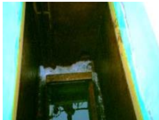
Figura 3.59. Canal principal frontal y canaletas secundarias
