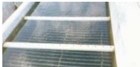
Figura 3.33 Zona de decantación mediante módulos de asbesto-cemento
