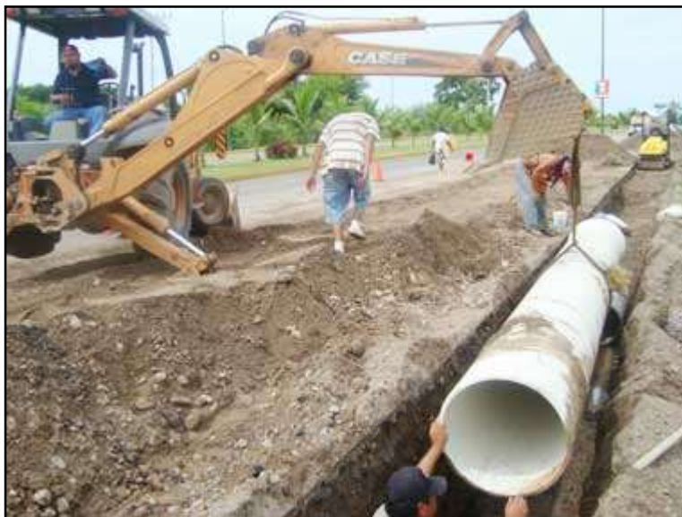
Figura 3. 1 Construcción de alcantarillado sanitario
