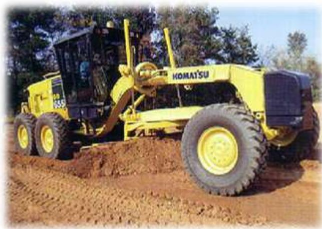
*Figura 2.16 Extendido de material con Motoniveladora*
