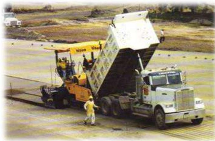
*Figura 2.17 Colocado de suelo cemento con Finisher*
